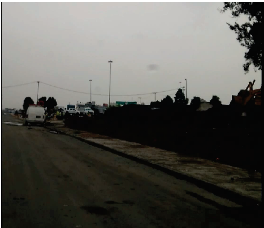
Imagen propia. Obra en la lateral del Río de los Remedios.
