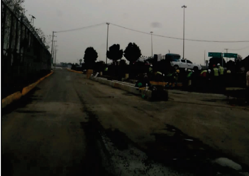
Imagen propia. Obra cercana al Río de los Remedios. Se constató la ausencia de transeúntes a lo largo de los días. Sólo hombres trabajando.
