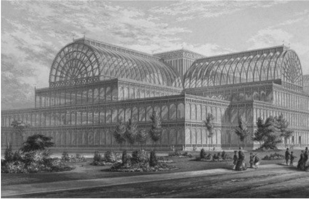
Figura 12. Vista exterior del Crystal Palace
