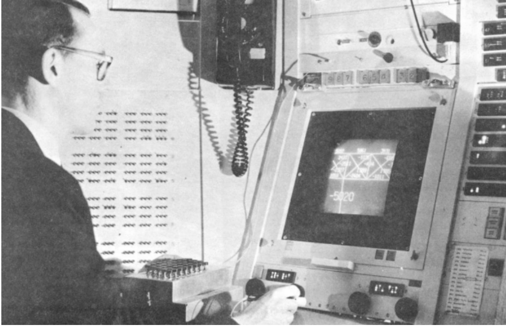
Figura 3. Ivan Sutherland operando el Sketchpad . Los botones ubicados debajo de la pantalla se utilizaban para controlar funciones específicas, al igual que para manipular el tamaño y posición del dibujo
