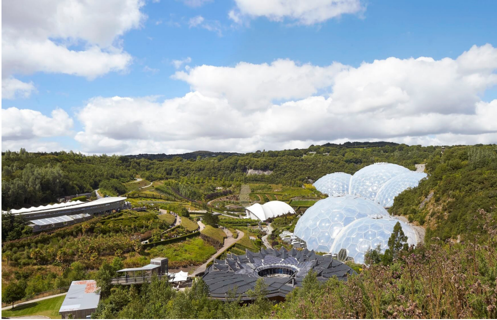
Figura 22. Vista panorámica del complejo
