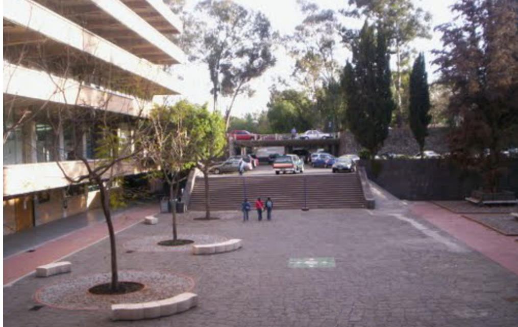
Figura 45. Plaza de los pinos de la facultad de arquitectura de la UNAM
