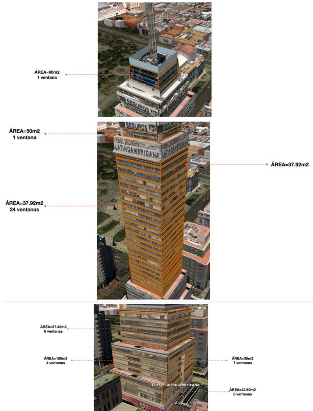
Figura 59. Cálculo de ventanas por secciones. Torre Latinoamericana. Elaboración propia a partir de imágenes de Google Earth.
