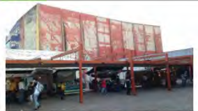
DAÑOS ESTRUCTURALES EN EDIFICIOS Y PÉRDIDA DE LA VIDA EN EL ESPACIO PÚBLICO.
