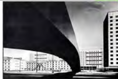
CONSTRUCCIÓN DEL CONJUNTO HABITACIONAL NONOALCO TLATELOLCO.
