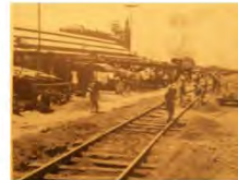
TRAMO FERROVIARIO DE TLATELOLCO-VILLA.
