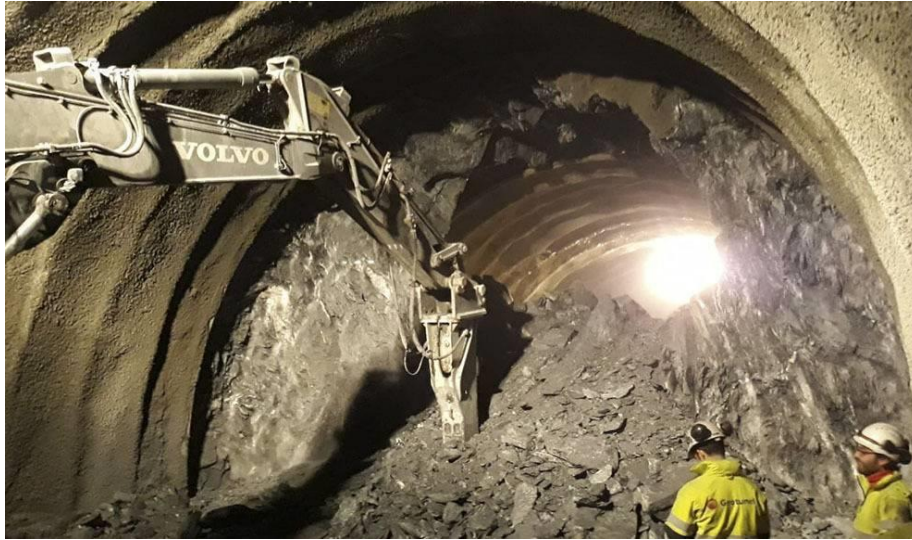
Ilustración 6. Excavación empleando equipo mecánico. Imagen: Adif finaliza la excavación de los 2.468 metros del túnel de Requejo, Tribuna Zamora, https://www.tribunazamora.com/noticias/adif-finaliza-la-excavacion-de-los-2-dot-468-metros-del-tunel-de-requejo.html
