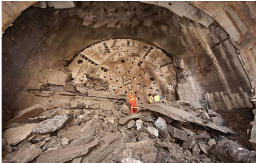
Ilustración 11. Excavación con tuneladora abierta. Foto: The Robbins Company.
