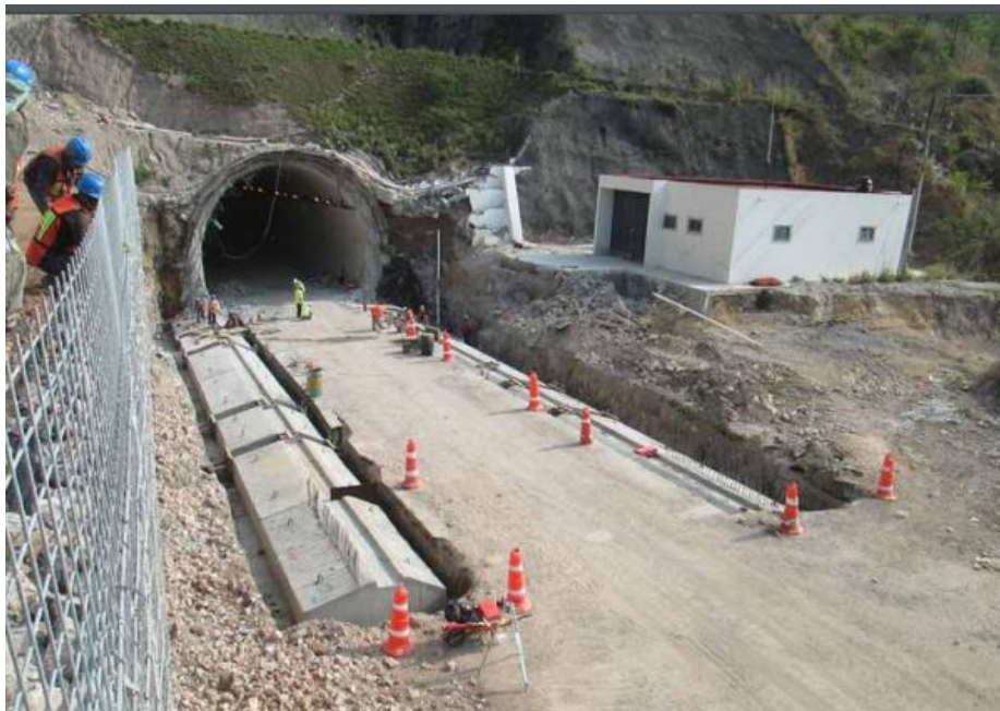
Ilustración 21. Zapatas prefabricadas para túnel falso durante la construcción en los Túneles “Obispo de Agua” de la Autopista Acapulco – Cuernavaca (Ing. F. Antonio Huelsz Noriega, 2015)
