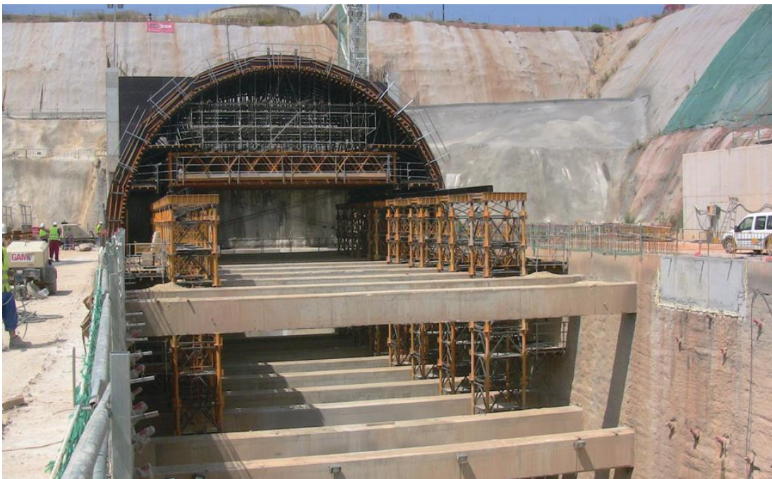
Ilustración 22. Cimbra deslizante para el colado del túnel durante la construcción del túnel falso "Prolongación de los ferrocarriles" en Terrassa, España. (Ulma Construction)
