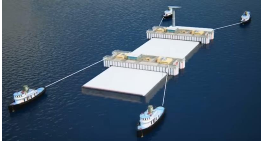
Ilustración 17. Transporte de elementos prefabricados; de Trelleborg - How to build an immersed tunnel
