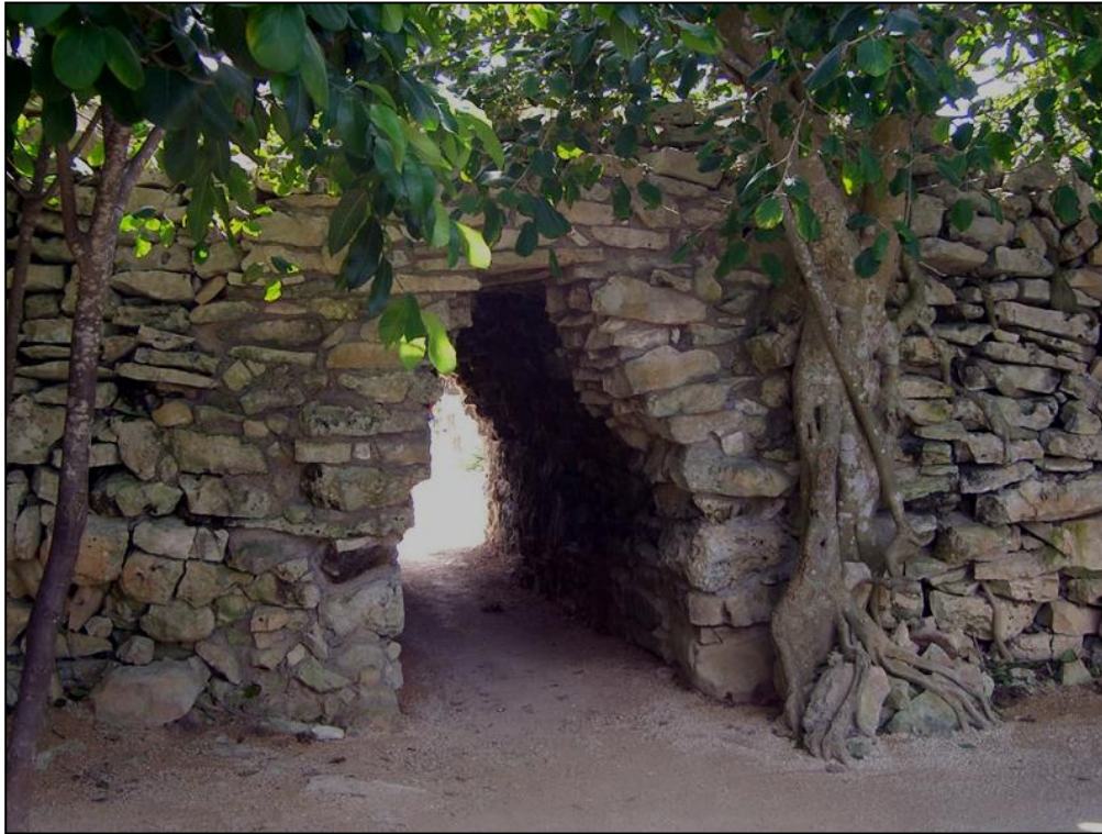
Figura 3.23 Acceso noroeste de la muralla.
