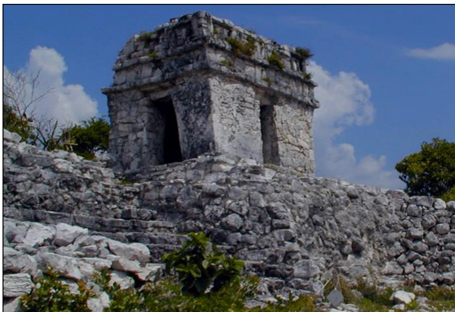
Figura 3.22 Torre Norte de vigilancia.
