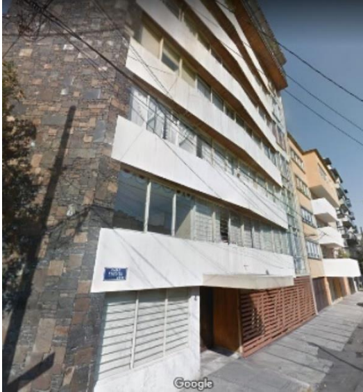
a) Antes del sismo, modificada de Google Earth, (2017)
