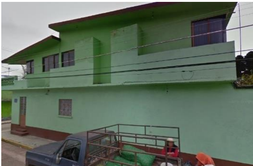
a) Antes del sismo, modificada de Google Earth, (2017)
