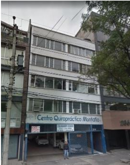
a) Antes del sismo, modificada de Google Earth, (2017)
