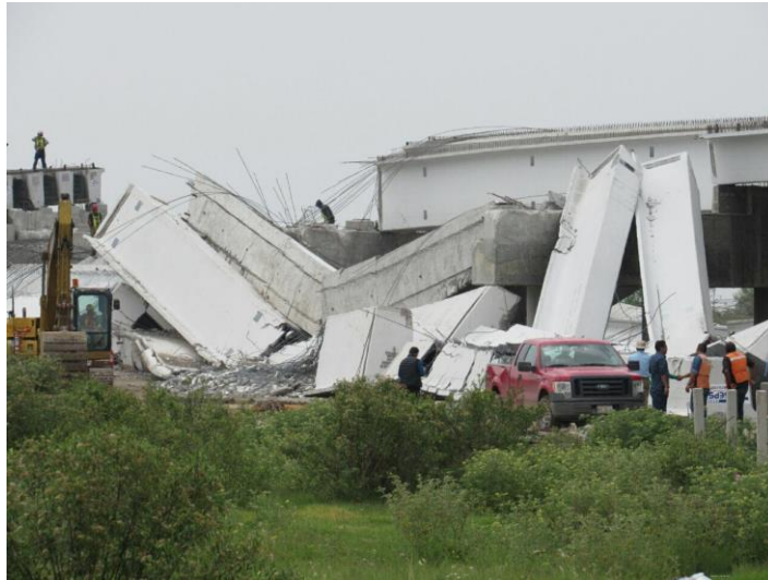
Figura IV.8. Puente en construcción de la nueva autopista Pirámides-Texcoco (La Jornada, 2017)
