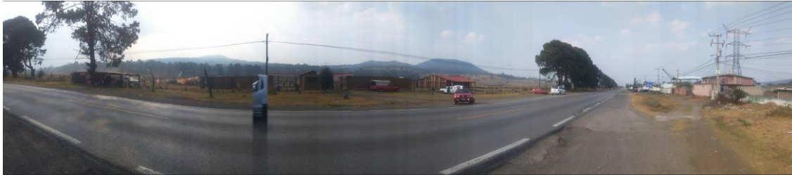
Vista del acceso al predio desde la acera opuesta al acceso principal. Fotografía de José Luis García Aguilar
