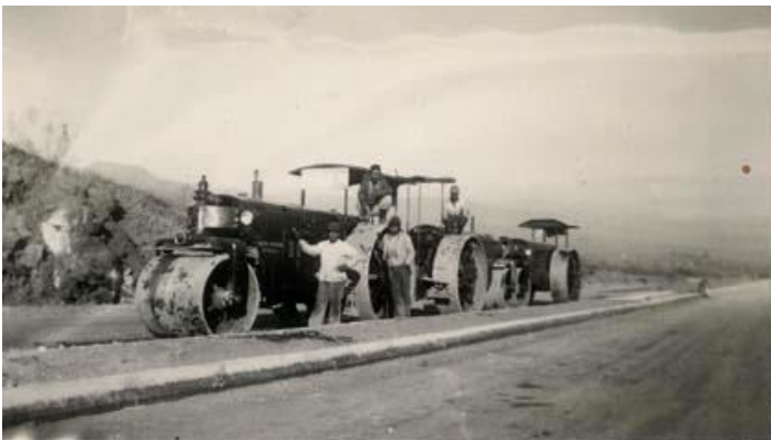
Etapa de conformación de sub base de la carretera de cuota a Cuernavaca.
