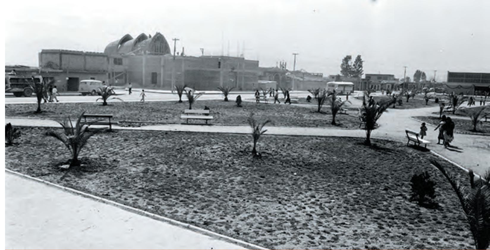
FIGURA 20. Parque de la calle Sur 16 en 1961, al fondo se observa la Parroquia de San Isidro en obra negra.
