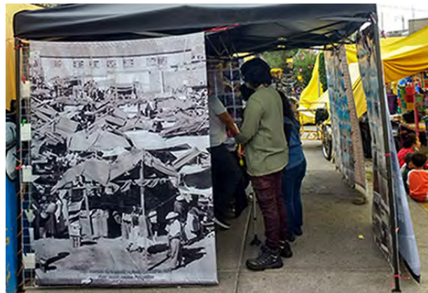
FIGURA 96. Vista desde el exterior del puesto-galería.
