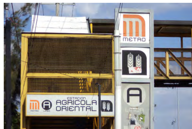
FIGURA 2. Entrada del Metro Agrícola Oriental.
