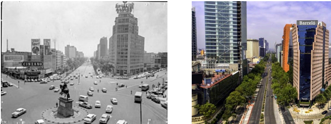
Imagen 10. Ubicación del demolido Edificio Corcuera y el actual hotel Barceló sobre Av. Reforma
