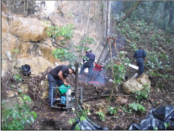
Perforación en la roca
