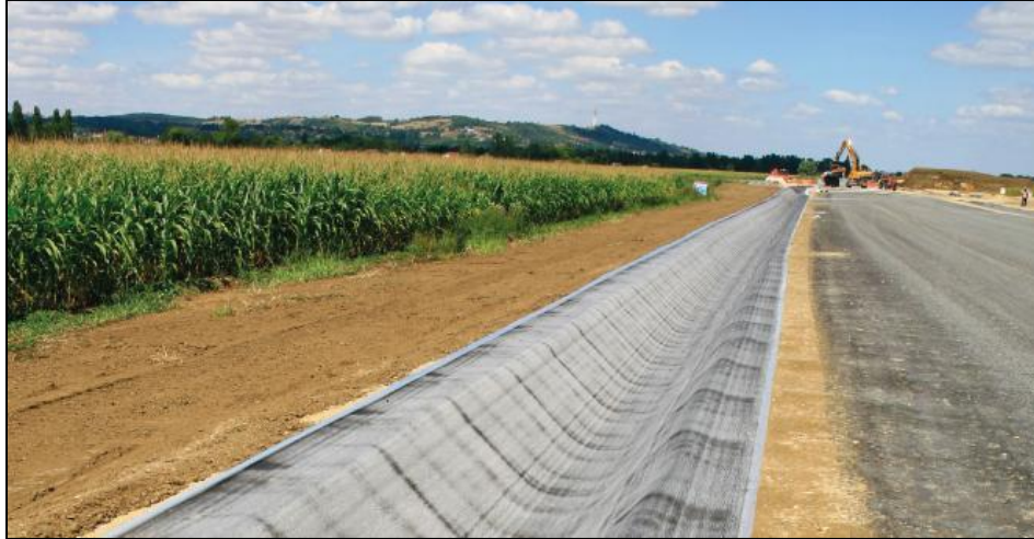
Figura 2.9. Cuneta (COLETANCHE, s.f.).
