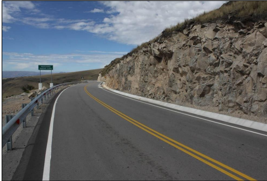
Figura 2.18. Pavimento flexible o asfáltico (Castillo, 2019).
