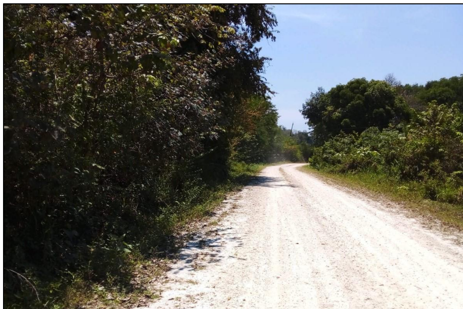
Figura 4.1. Subrasante y vegetación en la superficie del camino.
