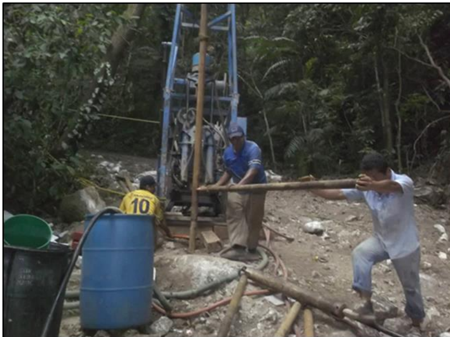
Figura 4.8. Sondeo para roca en el banco “Boca del Cerro”.
