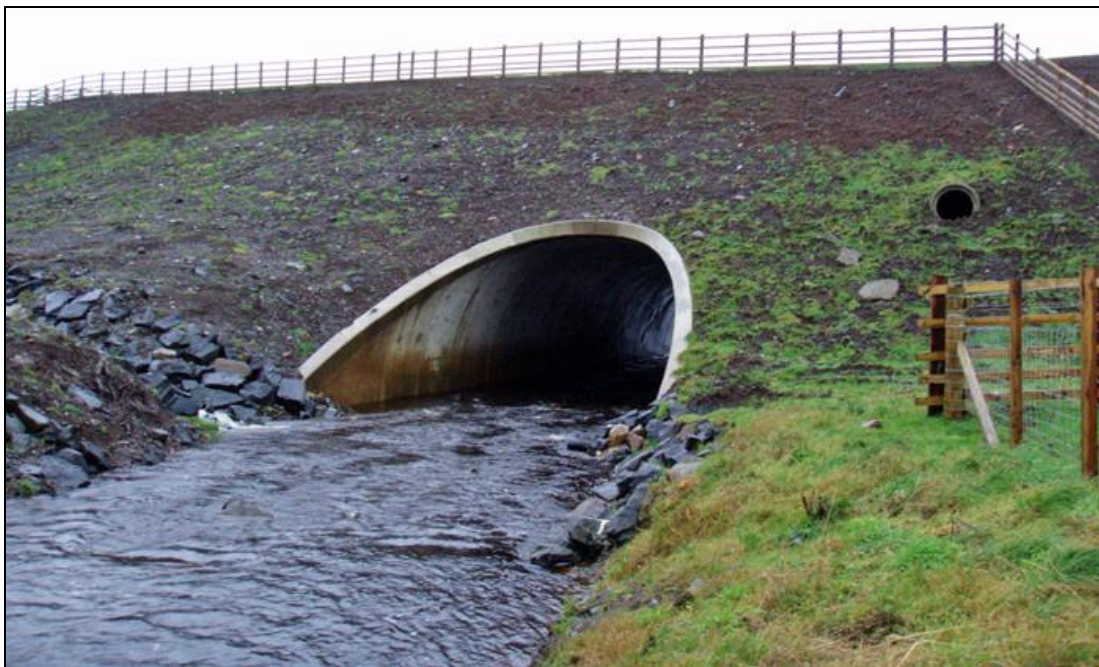
Figura 2.7. Bóveda (Tierra Armada, s.f.).
