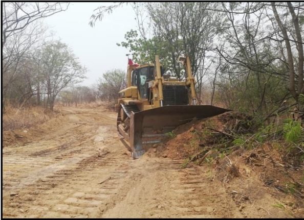
Fotos tomadas con mi celular del tractor realizando los trabajos de despalmes
