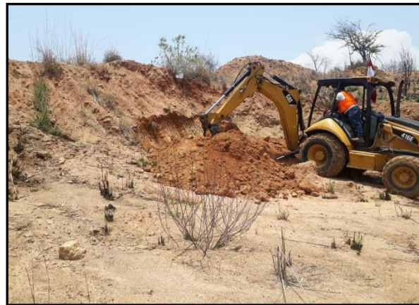
Foto tomada con mi celular de una Retroexcavadora haciendo retiro de material mejorado de un banco asignado, en el cual se utilizará para los trabajos de conformación.
