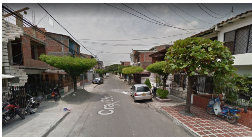
Imagen 7. Viviendas en el barrio Sindical, Carrera 28c
