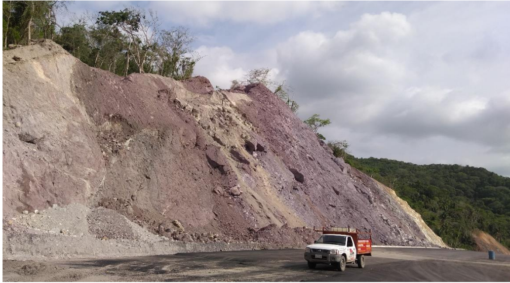
Ilustración 49 Talud vista del 03 de julio de 2018. Tomada de Reporte fotográfico SCT.
