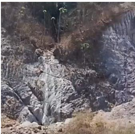
Ilustración 47 Zona de escurrimiento cadenamiento 71+100.
