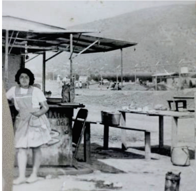
Imagen 8. Construcción de la planta de Pemex. Imagen proporcionada por Carlos Ricardo Márquez, en 2021
