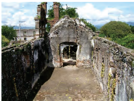
Ilustraciones 117 y 118: Fotografías del estado que guardaba el interior de la capilla al inicio de la investigación en el año 2006, sin ningún vestigio de cubierta. Fuente: Tomadas por Fernando Javier Flores Nájera
