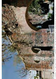
VISTA 3: FACHADA LATERAL SUR TOMADA DESDE EL SENNERO PARA MOSTRAR CONTRAFUERTE Y MUJERDA.
