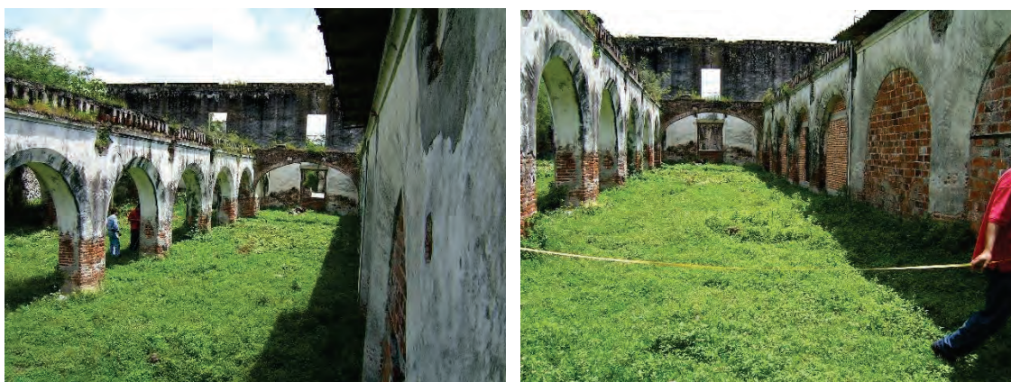
Ilustraciones 99 y 100: Fotografías del proceso del levantamiento arquitectónico de estado actual, en donde se puede apreciar la losa maciza adosada a mediados del siglo XX, las arcadas y los mechinales. Fuente: Tomadas por Fernando Javier Flores Nájera en el año 2007
