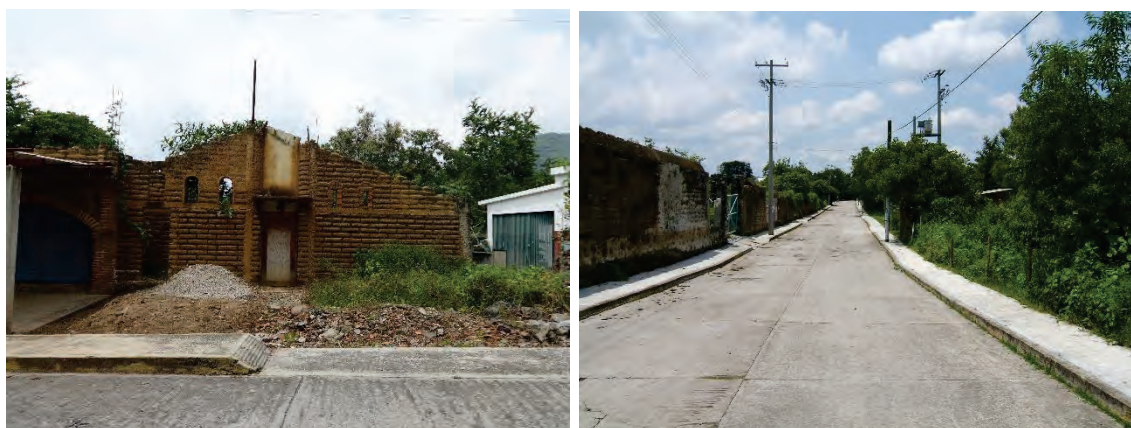
Ilustraciones 138 y 139: Fotografías de la construcción de adobe que probablemente haya albergado la garita y fotografía del sendero de penetración al conjunto de la hacienda. Fuente: Fernando Javier Flores Nájera.
