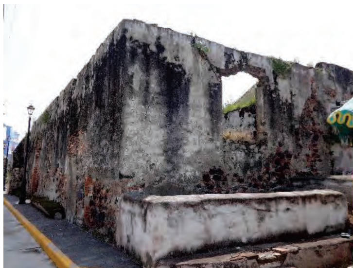
Ilustraciones 106 y 107: Fotografías de los muros de vestigio de los abrevaderos, es importante destacar que es de los pocos casos en la Hacienda en que están aplanados, cosa lógica en el sistema constructivo de muros de mampostería, ya que el mismo impide la penetración de agua y evita colapsos. Fuente: Tomada por Fernando Javier Flores Nájera en el año 2016
