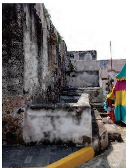
Ilustraciones 106 y 107: Fotografías de los muros de vestigio de los abrevaderos, es importante destacar que es de los pocos casos en la Hacienda en que están aplanados, cosa lógica en el sistema constructivo de muros de mampostería, ya que el mismo impide la penetración de agua y evita colapsos. Fuente: Tomada por Fernando Javier Flores Nájera en el año 2016
