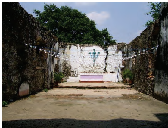
Ilustraciones 117 y 118: Fotografías del estado que guardaba el interior de la capilla al inicio de la investigación en el año 2006, sin ningún vestigio de cubierta. Fuente: Tomadas por Fernando Javier Flores Nájera
