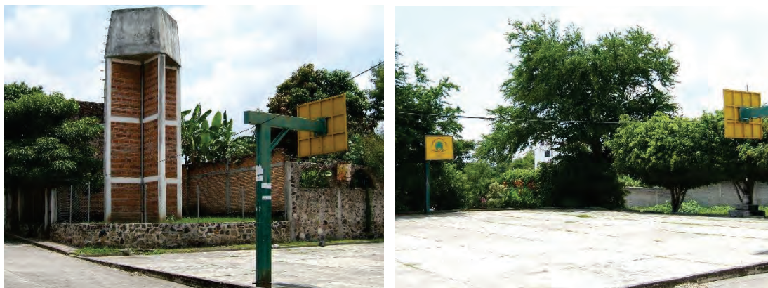
Ilustraciones 144 y 145: Fotografías de la cancha de basquetbol y del tanque elevado. Fuente: Tomadas por Fernando Javier Flores Nájera.
