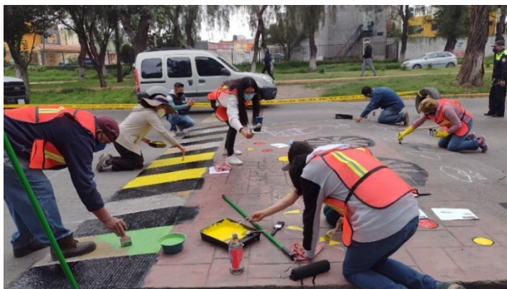
Foto: Colectivo Áurea, Proceso de realización del cruce peatonal, octubre 2021
