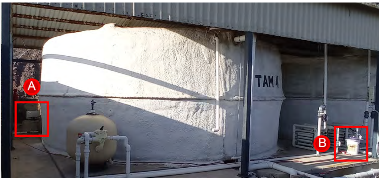
Figura 5.27: Ubicación del gateway y del end-device con uno de los tanques como interferencia.
