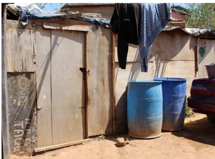
Figura 10. Recámara con muros de material de desecho. Fuente: elaboración propia.
