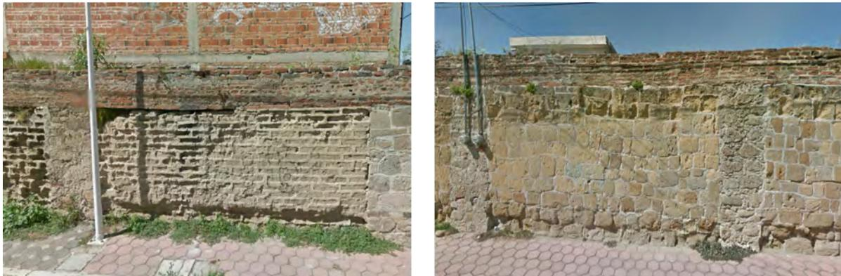
Fig. 20 Muro-acueducto de bloques de adobe (izq.) y de piedra arenisca (der.).
