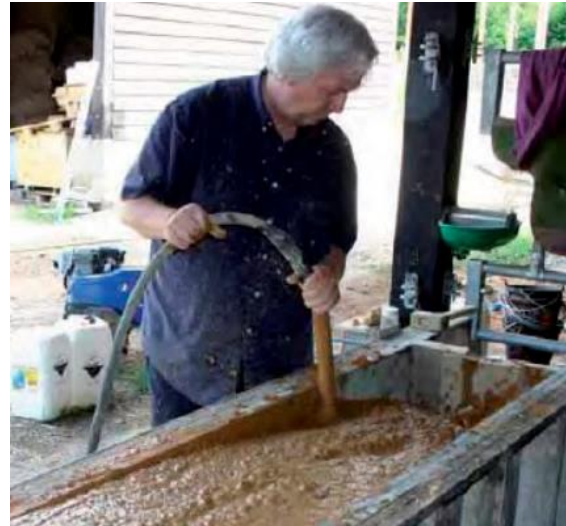
Figura 6: Elaboración de un muro con tierra vertida a la que se le agregan aditivos.
