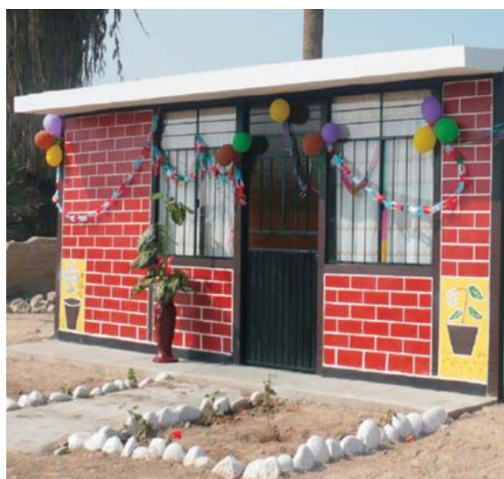
Figura 8: Vivienda de quincha con revestimiento y pintura que simula ladrillos.
