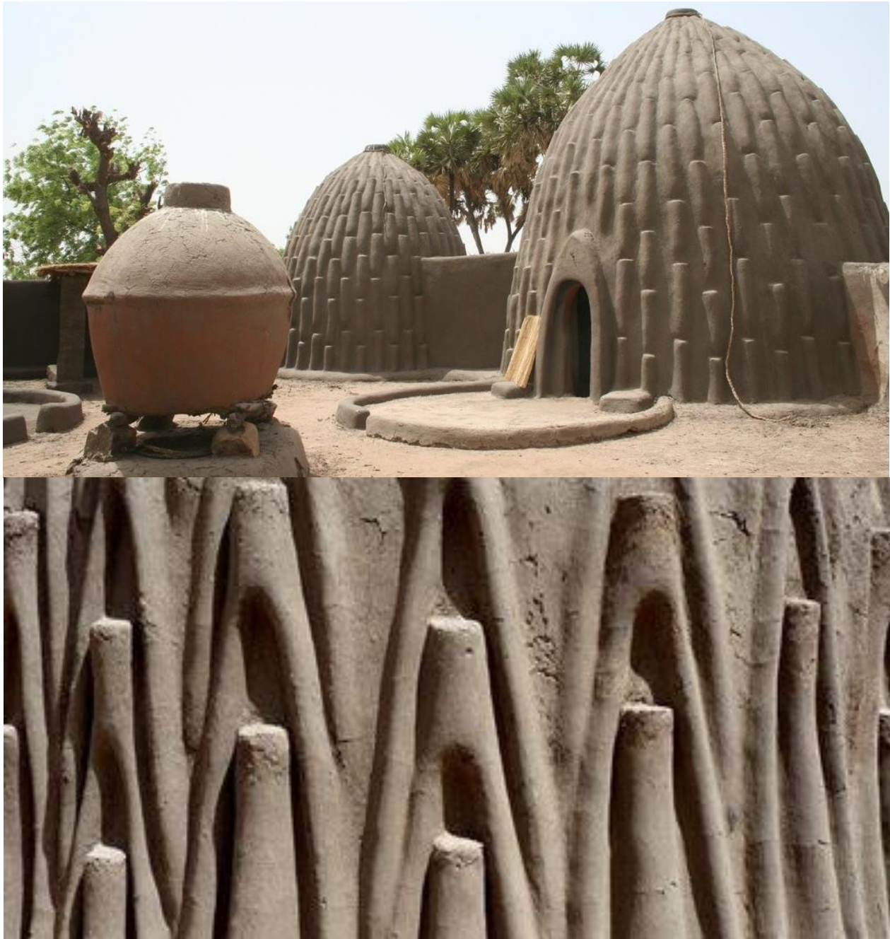
Figura 18: Patrón geométrico de los recubrimientos de muros en las viviendas Tolek, construidos con tierra.
