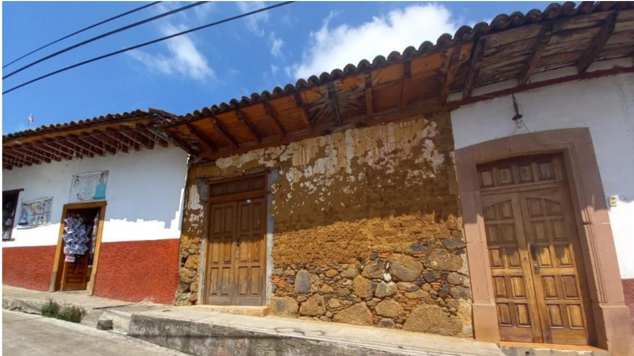
Figura 21: Detalle de la cimentación a base de piedra y muro de adobe con paja.
