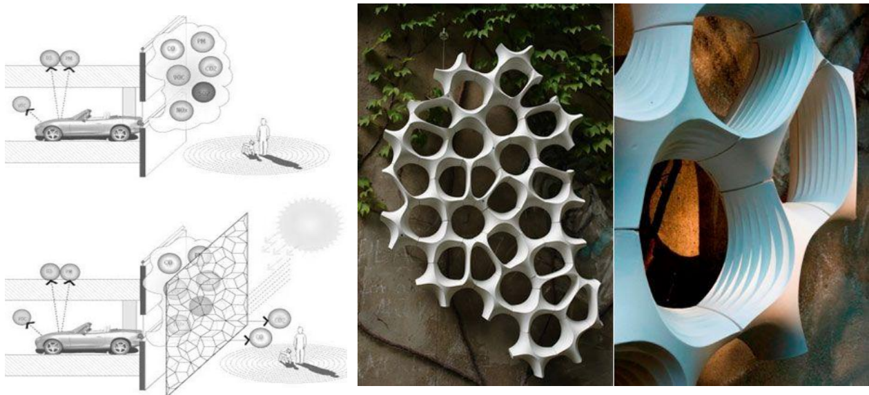
Figura 15: Paneles de la fachada principal del Hospital General Manuel GEA González, Ciudad de México.
