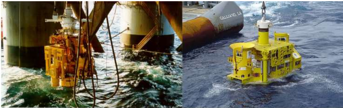
Figura 6.1 Instalación del árbol con tubería (izquierda) y con cable (derecha) 81
