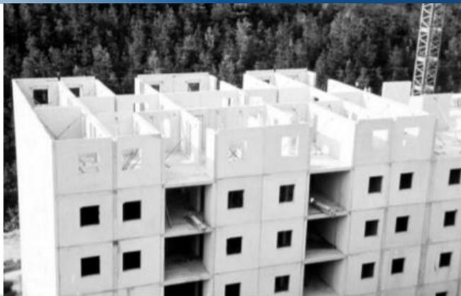
Notas: La imagen ejemplifica el uso de sistemas cerrados para vivienda vertical, al ajustar el diseño a los componentes del sistema constructivo. Obtenido de Salas J., los sistemas de prefabricación cerrada a la industrialización sutil de la edificación: algunas claves del cambio tecnológico. 2008.
