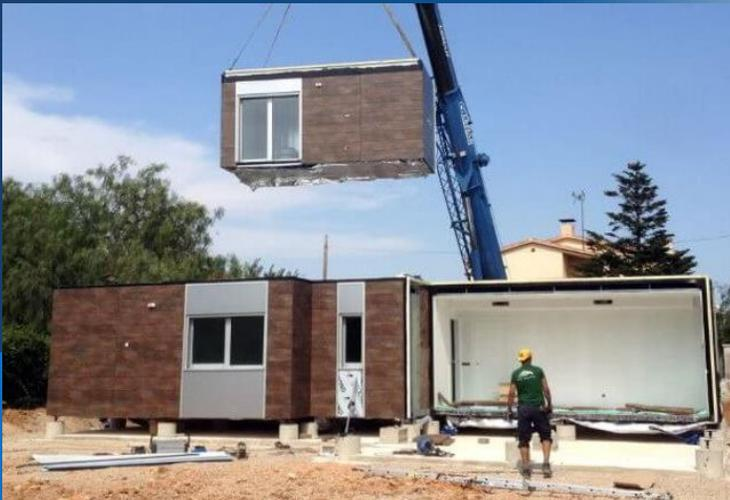
Notas: En la imagen se muestra el proceso de ensamblaje de elementos prefabricados.
