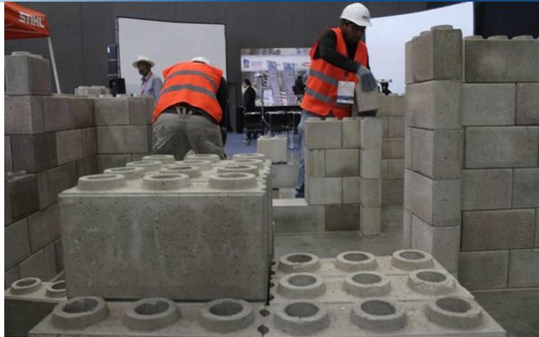
Nota: La imagen se observa la propuesta de fabricación de block tipo lego para muros.
