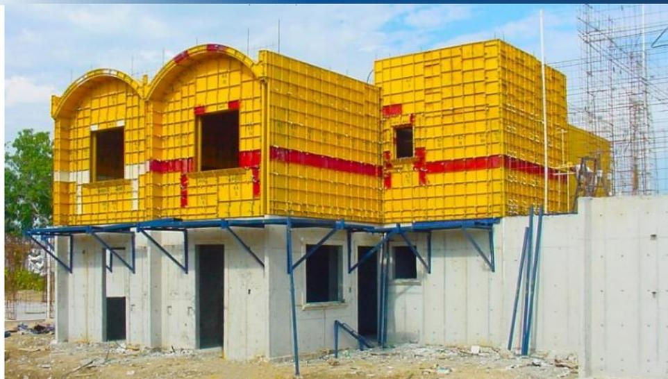
Notas: Este sistema constructivo es muy eficiente en tiempo de ejecución, aunque el costo de fabricación de molde impacta en el presupuesto final y restringe la diversidad de prototipos. Obtenido de <https://www.meccano.mx/>
