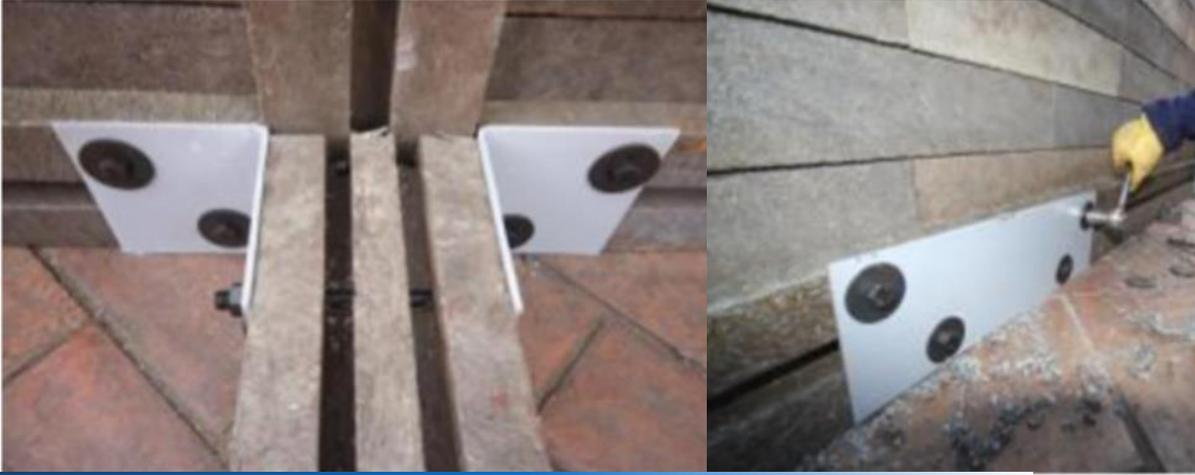
Nota: Se muestran ejemplos de anclajes por medio de platinas metálicas y tornillería para garantizar la sujeción de elementos plásticos. En caso de sismo los tornillos están diseñados para ceder y absorber los movimientos de la estructura, con este sistema no se evita el uso de algún agente adherente o cementante. Obtenido de Manual de Grupo Bloqueplas de México, (2022, p. 6).
