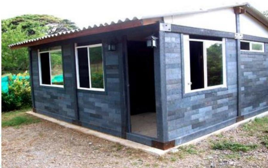
Notas: Fotografía de sistema constructivo con base en elementos prefabricados de plástico enmarcado por estructura metálica.
