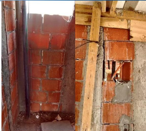
Nota: En las imágenes se observan deficiencias en el habilitado de piezas de mampostería, originadas por el mal manejo de las piezas, demoliciones parciales para alojar instalaciones y cantidad inadecuada de mortero utilizado en las juntas, elaboración propia.
