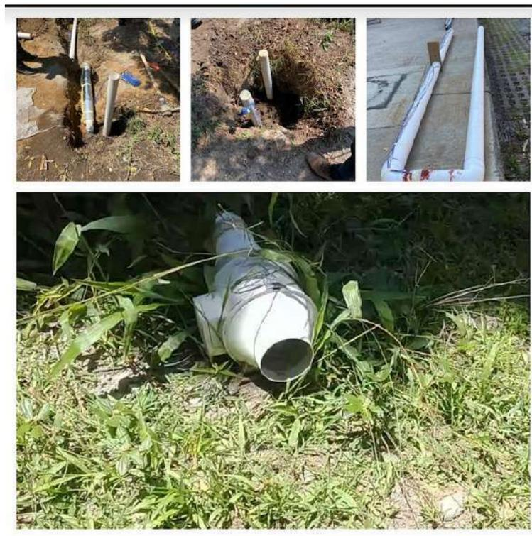
**Figura 3.18:** Fotografías del intercambiador de calor durante su instalación
