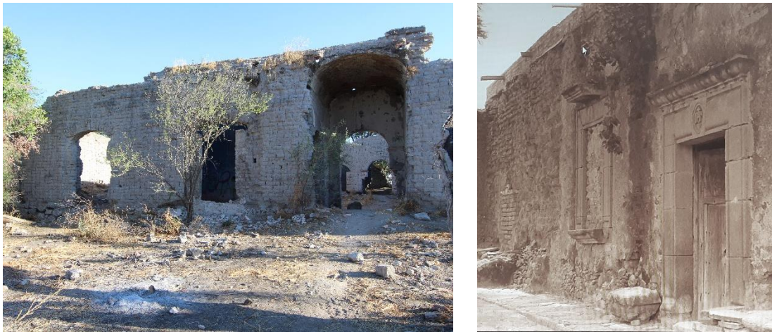
Ilustración 28 Cimentación de mampostería de piedra y muros a base de adobes en las haciendas de Buenavista y El Saúz. | Elaboración propia. 2022 (izquierda). Archivo Histórico de Aguascalientes (derecha).
