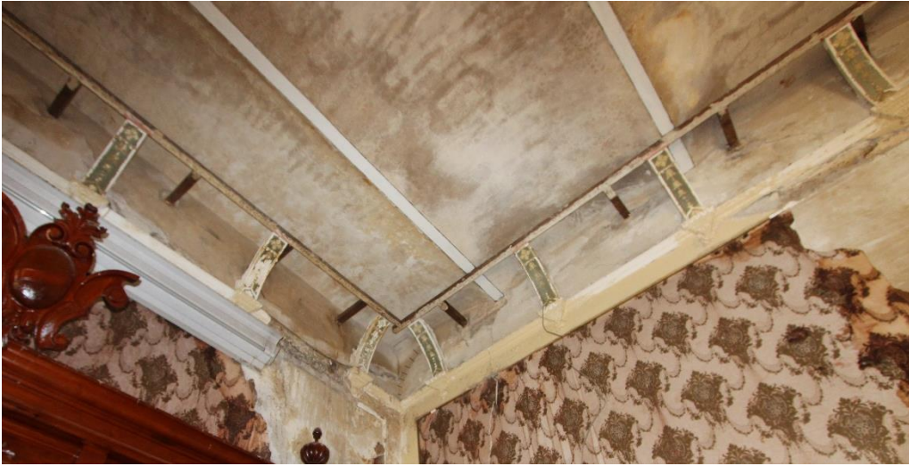
Ilustración 116 Vista del cielorraso en el comedor de la casa grande de Cañada Honda | Elaboración propia. 2021.
