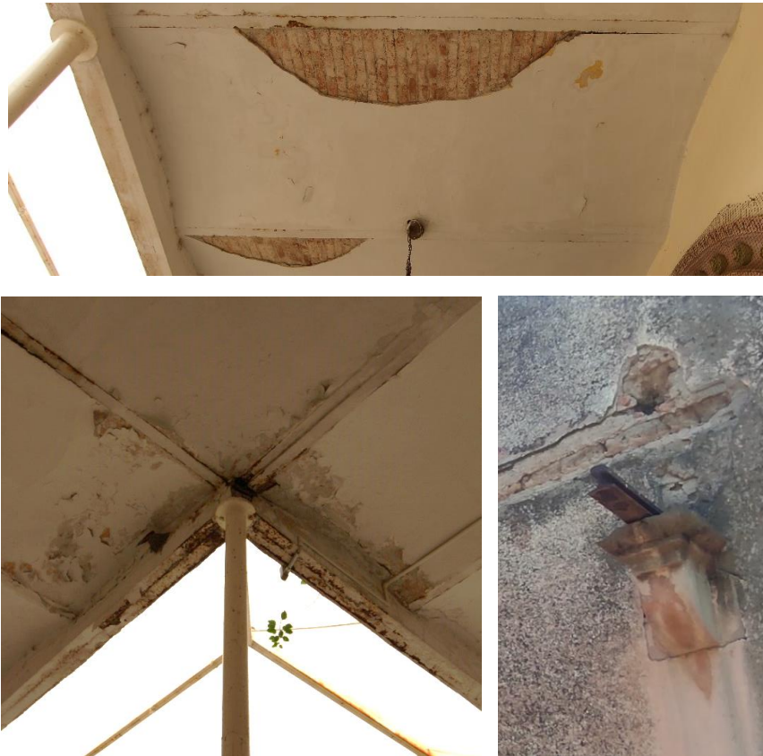
Ilustración 209 Muestras de materiales y sistemas constructivos innovadores en las casas grandes porfirianas de Aguascalientes. Vigas, viguetas y columnas metálicas, y sistema de cubierta con bóveda catalana | Elaboración propia. 2022.
