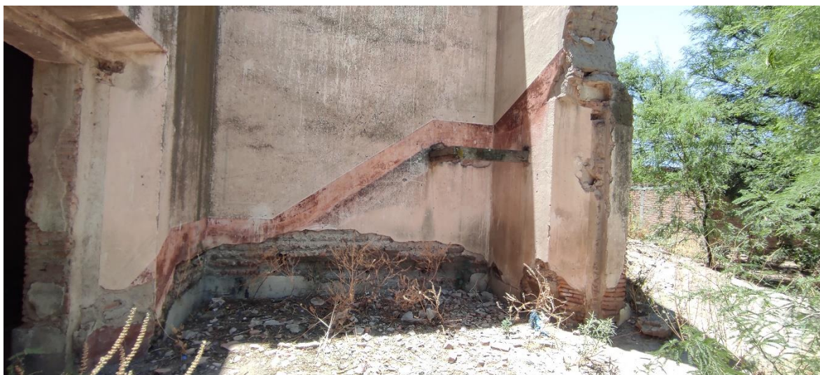
Ilustración 139 Restos de la escalera de madera que comunicaba ambas plantas. | Elaboración propia. 2022.
