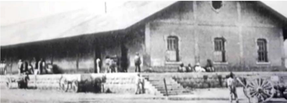
Ilustración 20 Bodega de almacenamiento de carga del ferrocarril en Aguascalientes, podemos apreciar la techumbre de lámina | Yacimientos: Inicio de los talleres ferrocarrileros. Aguascalientes, Ags. México. (Facebook).
