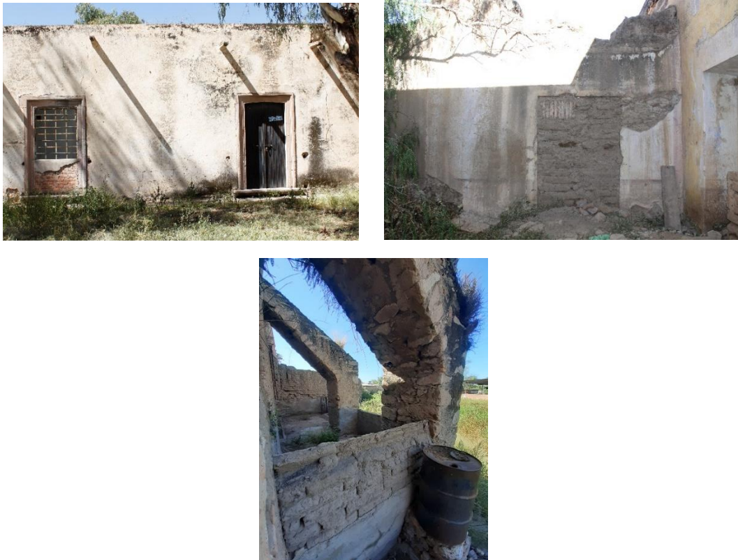
Ilustración 225 Agregados. Arriba a la izquierda, murete de ladrillo con herrería y puerta de lámina. Arriba a la derecha, murete de adobe a modo de tapial en vano de puerta. Abajo, murete de adobe para construcción de corral.
