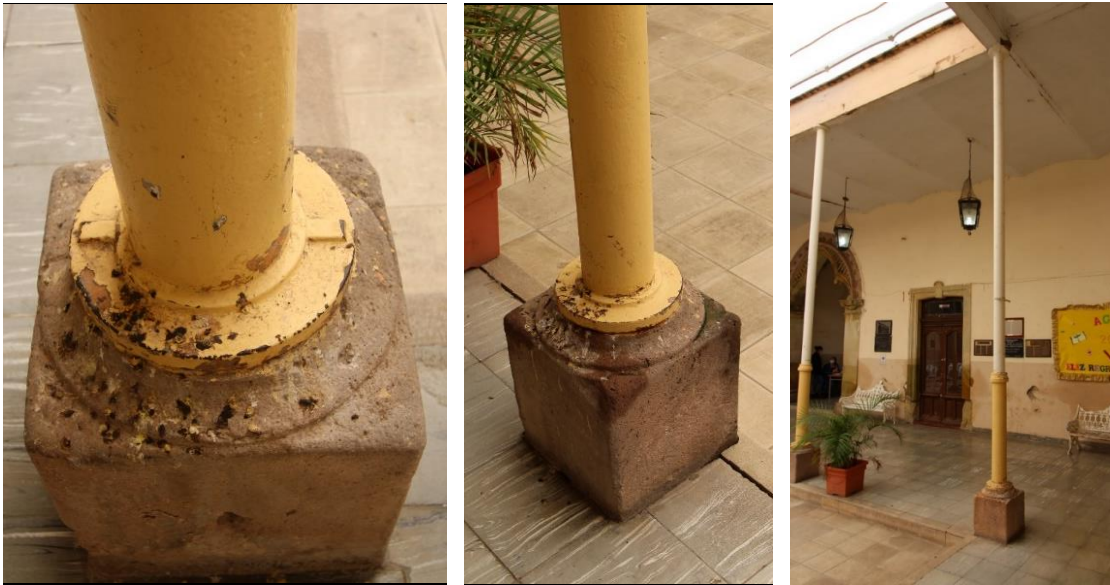
Ilustración 106 Detalle de dado o base de piedra, columna metálica y cubierta a base de bóveda catalana con estructura metálica. | Elaboración propia. 2021.
