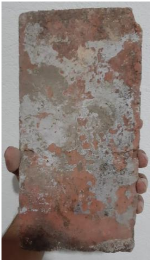
Ilustración 53 Piezas de ladrillo rectangulares empleados en muros. | Elaboración propia. 2020
