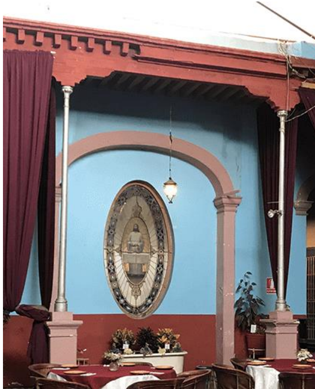
Ilustración 107 Columnas del patio principal de la casa conocida actualmente como la “Saturnina”. Aún mantiene un sistema mixto entre elementos de madera y la introducción de columnas metálicas. | Manual Técnico de Procedimientos para la Rehabilitación de Monumentos Históricos en el Distrito Federal (dibujo). Secretaría de Economía Social y Turismo Municipal. La Saturnina. Siglo XX (fotografía).
