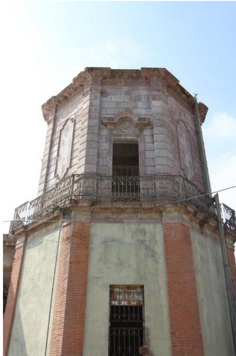
Ilustración 101 Torre anexa a la casa grande. Destacan los materiales empleados (ladrillo colado y cantera rosada, hierro en barandales). Así como su función de tanque elevado | Elaboración propia 2021.
