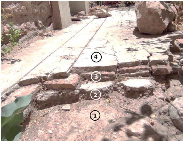
Ilustración 129 1 Se observan las siguientes capas en la composición de pisos: (1) cama de tierra-material inerte apisonada, (2) capa de material pétreo de aproximadamente 2 centímetros de diámetro con mortero cal-arena, (3) ladrillo asentado con mortero cal-arena, (4) piso de concreto estampado y entintado.
