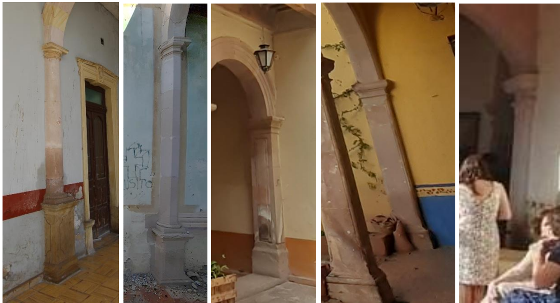
Ilustración 202 Impostas y columnas adosadas en los patios de las casas grandes de Aguascalientes. | Elaboración propia. 2022.
