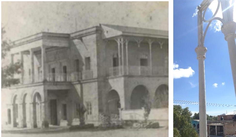
Ilustración 169 Columnas y ménsula metálicas de la cubierta en la terraza lateral de la casa grande de Palo Alto. | Aguascalientes mx, un rincón del pasado, fotos antiguas (izquierda). Elaboración propia. 2022. (derecha).
