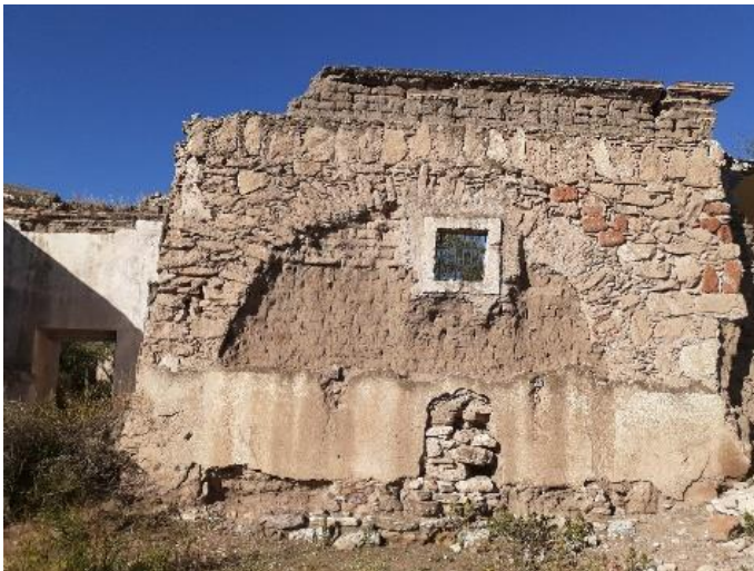
Ilustración 56 Muro con arco de descarga de mampostería de piedra. | Elaboración propia. 2020
