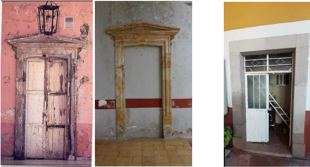
Ilustración 214 A la izquierda, acceso en fachada lateral de Cañada Honda modificada. A la derecha, agregados no reversibles, alteración de la zonificación e instalaciones en un espacio principal| Elaboración propia. 2022.
