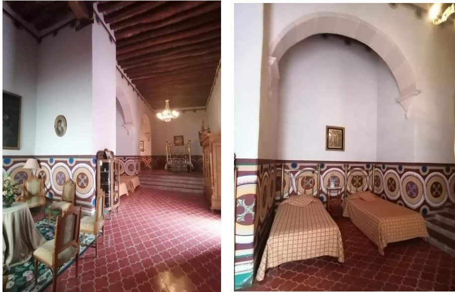
Ilustración 174 Fotografías del interior de la casa grande de La Guayana. Se puede ver el empleo de arcos de piedra, muros de adobe, cubiertas con envigados de madera, ladrillo en los remates de pretilas, dinteles y puertas de madera. | MexicaLives (Facebook).
