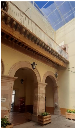
Ilustración 168 Sistema constructivo de entepiso en la casa grande de Palo Alto. | Manual Técnico de Procedimientos de para la Rehabilitación de Monumentos Históricos en el Distrito Federal. (Croquis). Elaboración propia. 2022. (Fotografía).
