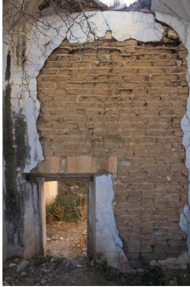
Ilustración 54 Muro a base de adobes de una de las habitaciones de la casa grande del Soyatal | Elaboración propia. 2020.
