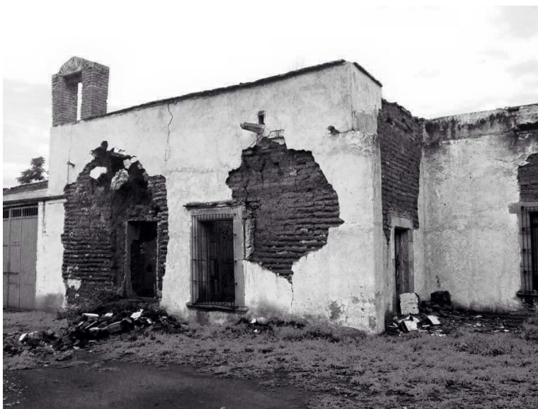
Ilustración 178 Fachada de la casa grande de la hacienda La Primavera, en el municipio de Calvillo, Aguascalientes. | Archivo Histórico de Aguascalientes.
