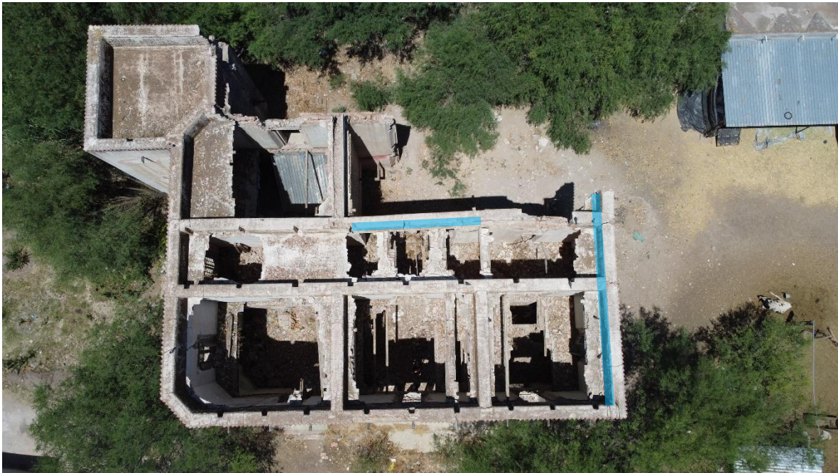
Ilustración 132 Vista aérea en dónde se señalan las vigas metálicas a base de riel que se observan a simple vista | Elaboración propia. 2022.
