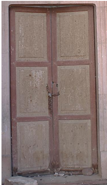
Ilustración 83 Única puerta original existente en la casa. | Elaboración propia. 2020.
