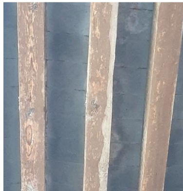
Ilustración 67 Cubierta a base de vigas de madera y ladrillo. | Elaboración propia. 2020
