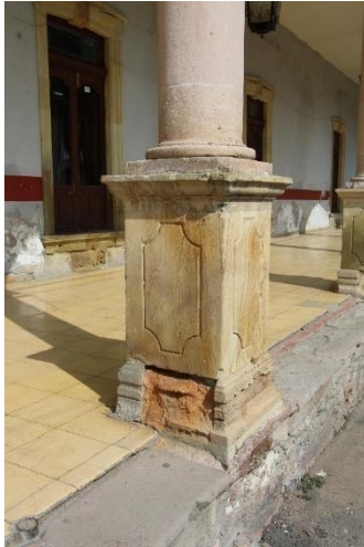
Ilustración 103 También se observa el sistema constructivo empleado, en este caso adiferencia de la Ciudad de México, donde también se empleaba recinto, se utilizó la cantera de Clavellinas | Elaboración propia 2021. (izquierda). Manual Técnico de Procedimientos para la Rehabilitación de Monumentos Históricos en el Distrito Federal.
