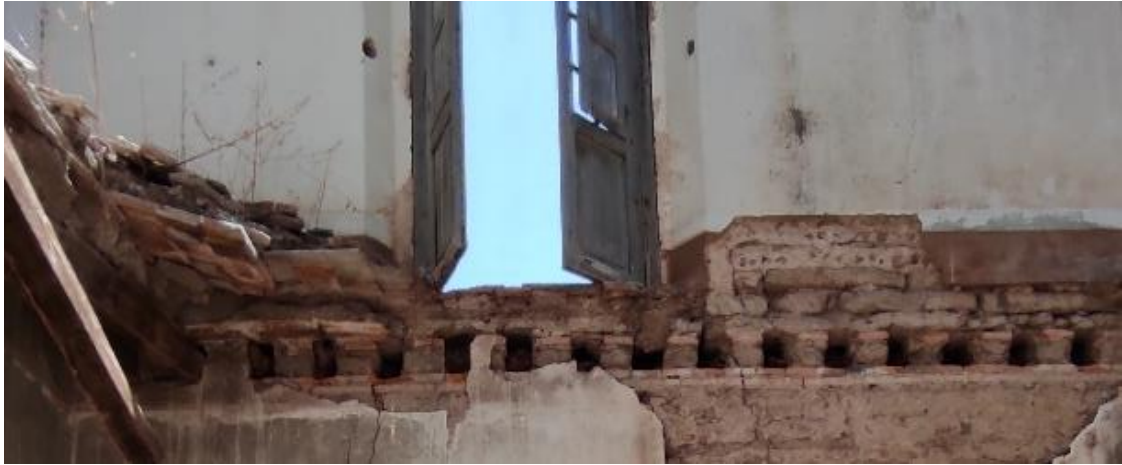
Ilustración 131 Vista del sistema constructivo de entrepisos y cubiertas. Se emplea el sistema tradicional con vigas de madera, en este caso destaca la proximidad entre vigas. | Elaboración propia. 2022.
