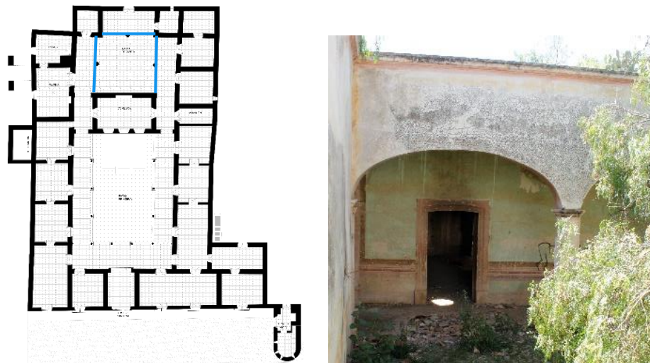
Ilustración 78 Arcos a carpanel ubicados en el patio trasero. | Elaboración propia. 2020.
