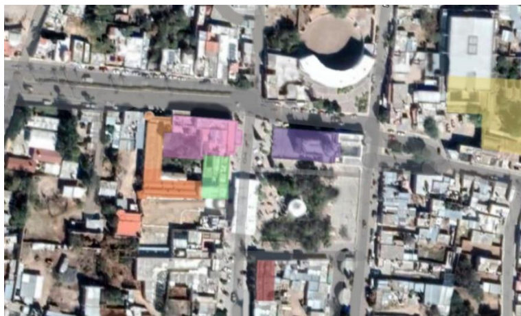
Ilustración 164 Vista aérea del estado actual del antiguo casco de la hacienda de Palo Alto. Se señalan varios de sus edificios originales. | Elaboración propia. 2022.
