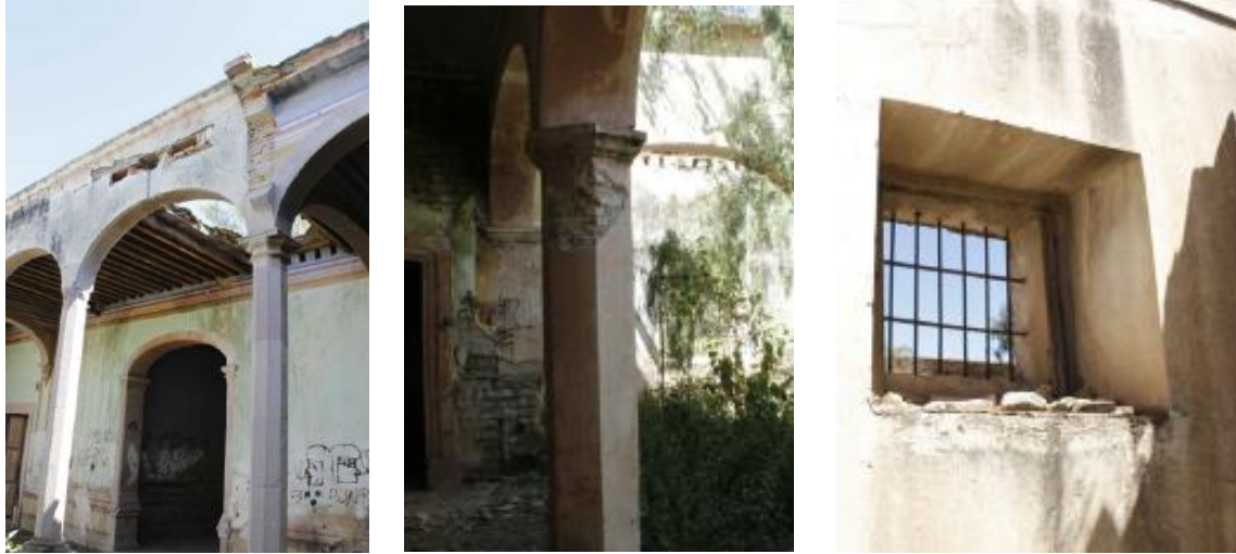
Ilustración 220 Arriba, piso a base de ladrillo rojo, puerta de madera original y enmarcamiento. Abajo, columna con cantera, columna a base de ladrillo y herrería en ventana. | Elaboración propia. 2020.
