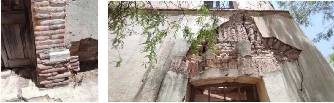
Ilustración 130 Ladrillo y adobe en muros de la casa grande de La Punta. | Elaboración propia. 2022.
