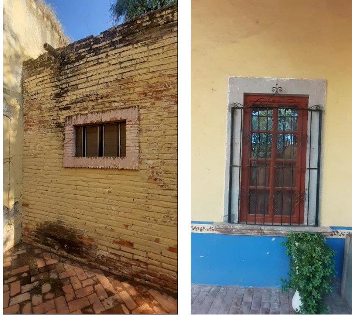
Ilustración 149 Muros de adobe y ladrillo en la casa grande de Garabato. | Elaboración propia. 2022.
