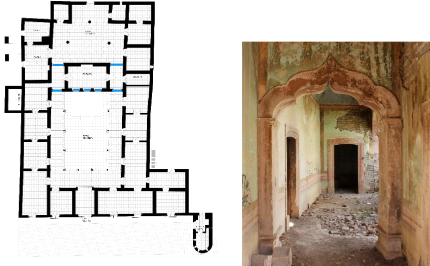
Ilustración 79 Arcos conopiales en pasillos de conexión de los patios y en la fachada del comedor. | Elaboración propia. 2020.
