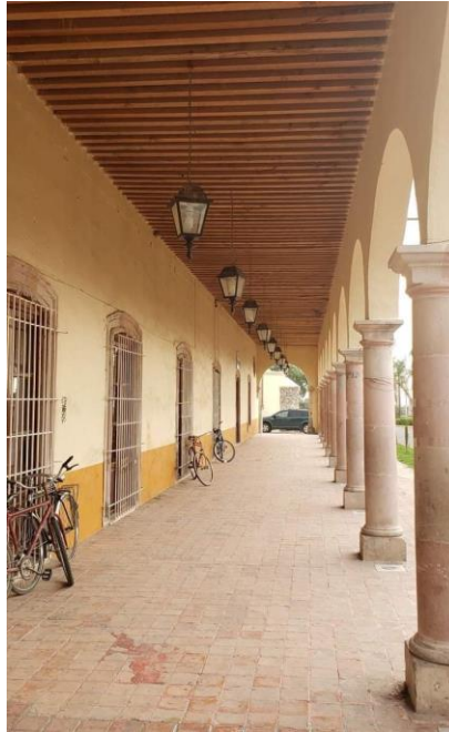
Ilustración 167 Corredor exterior de la casa grande de Palo Alto. Se pueden apreciar las columnas y enmarcamientos de cantera, los arcos de medio punto, las vigas de madera y el piso de ladrillo. | Elaboración propia. 2022.
