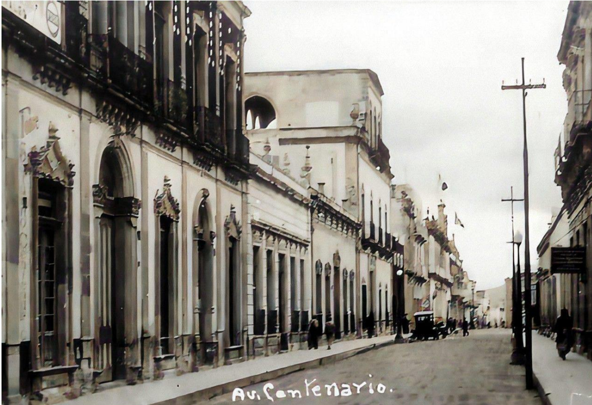
Ilustración 40 Edificios en la avenida Centenario. Se aprecia el exhibicionismo social mediante la ornamentación de fachadas, así como la simetría y el ritmo de las fachadas | Hotel Centenario. Aguascalientes, Ags. México. (Facebook).
