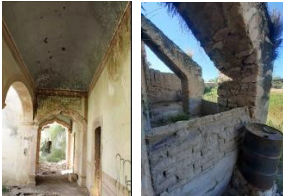
Ilustración 221 A la izquierda, bóveda en corredor. A la derecha, arbotante de refuerzo para bóveda de la cocina. | Elaboración propia. 2020.
