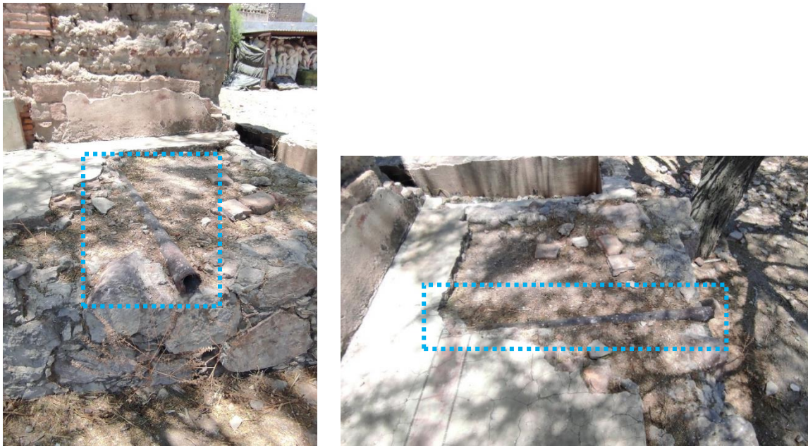
Ilustración 138 Desagüe de la cocina. | Elaboración propia. 2022.
