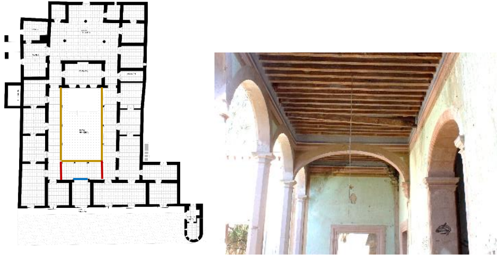
Ilustración 77 Arcos rebajados en el patio principal. | Elaboración propia. 2020.
