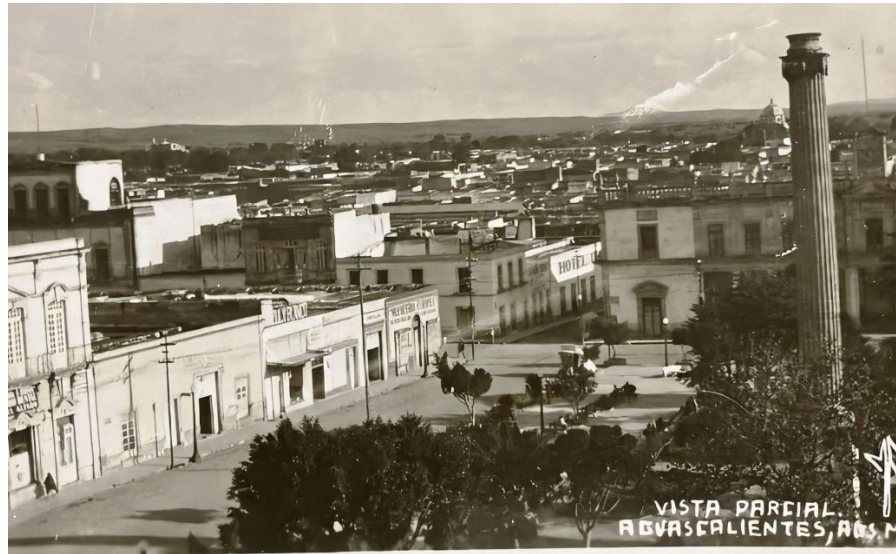
Ilustración 25 Tipología de vivienda tradicional (colonial) de Aguascalientes | Aldo Bonilla Chávez. Facebook: Aguascalientes, Ags. México
