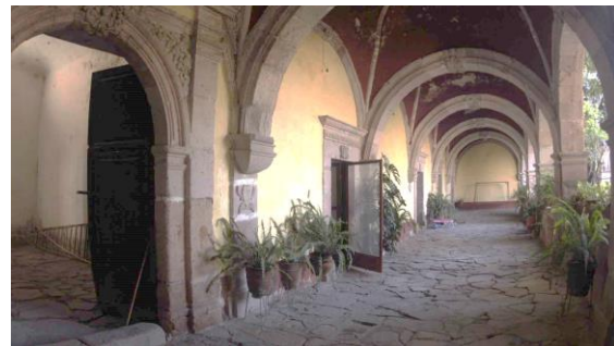
Ilustración 33 Trabajos de cantería y cubiertas a base de bóvedas de crucería al interior de la casa del hacendado de Cieneguilla. | Armando Jasso. Facebook: Edificaciones Coloniales de Todo México.
