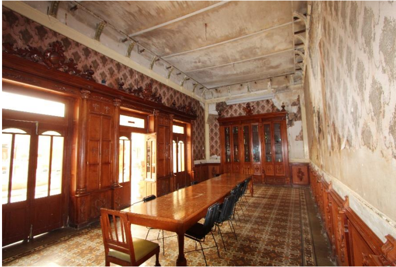
Ilustración 114 Ebanistería y carpintería de guardapolvos, enmacamientos y vitrinas del comedor de la casa grande de Cañada Honda. | Elaboración propia. 2021.
