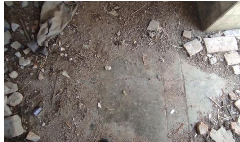
Ilustración 129 1 Se observan las siguientes capas en la composición de pisos: (1) cama de tierra-material inerte apisonada, (2) capa de material pétreo de aproximadamente 2 centímetros de diámetro con mortero cal-arena, (3) ladrillo asentado con mortero cal-arena, (4) piso de concreto estampado y entintado.
