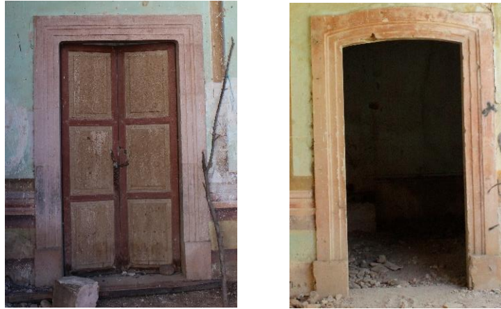
Ilustración 80 A la derecha enmarcamiento de cantera rosa. A la izquierda enmarcamiento fabricado con ladrillo. | Elaboración propia. 2020.
