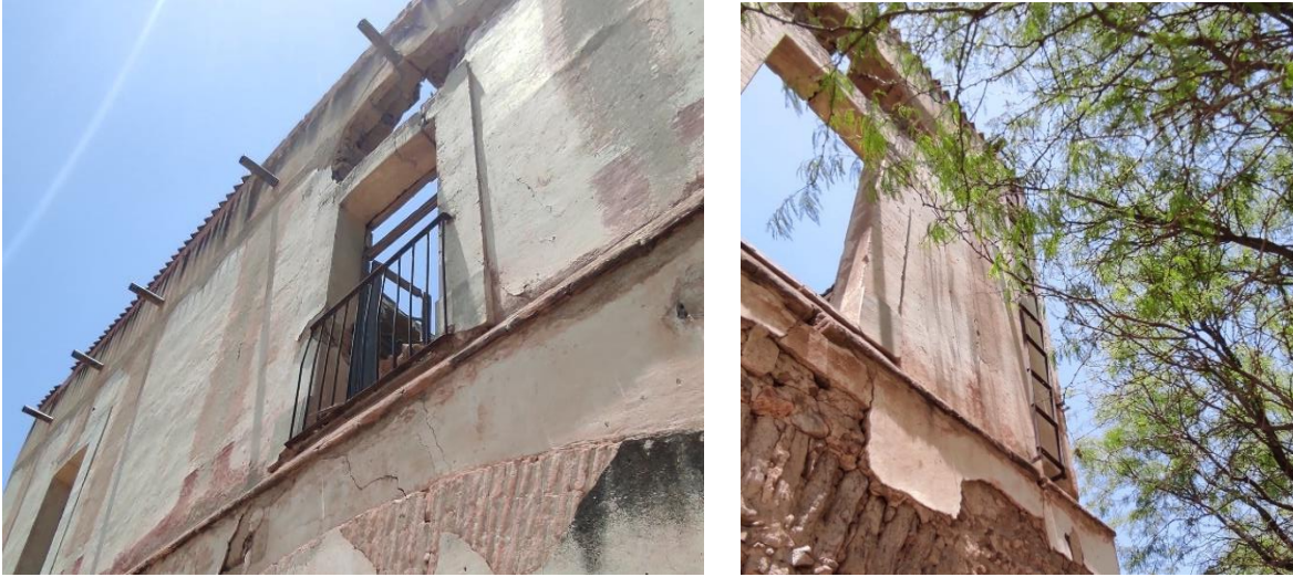
Ilustración 135 Barandal y escaleras verticales metálicas. Elaboración propia. 2022.
