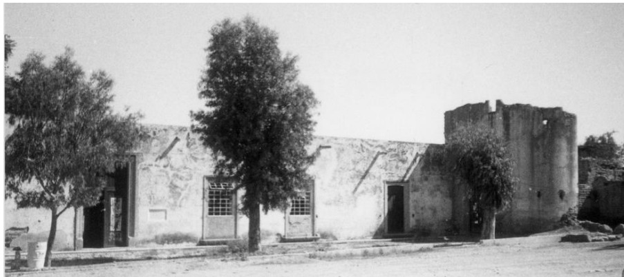
Ilustración 92 Fachada principal, casa grande de la hacienda el Soyatal | INAH Aguascalientes.
