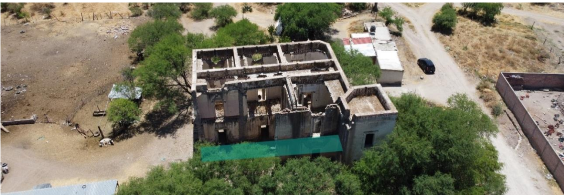
Ilustración 122 Terrazas exteriores de la casa grande de la hacienda La Punta. Se indica en color azul la ubicación hipotética de terrazas exteriores basada en la observación física del edificio. Las que se encuentran en planta alta están conectadas con todas las habitaciones, y la que se ubica en planta baja con el comedor | Elaboración propia. 2022.
