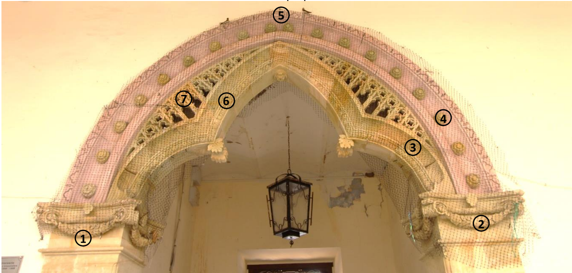
Ilustración 119 Trabajo de cantería en el arco del acceso al patio central de la casa grande de Cañada Honda. | Elaboración propia. 2021.
