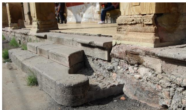
Ilustración 102 Escalera en el acceso principal, se puede ver que anteriormente contaba con barandal de herrería. | Elaboración propia 2021.
