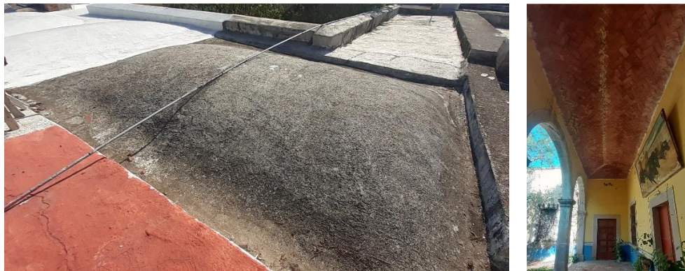
Ilustración 150 Bóvedas a base de ladrillo, casa grande del Garabato. | Elaboración propia. 2022.
