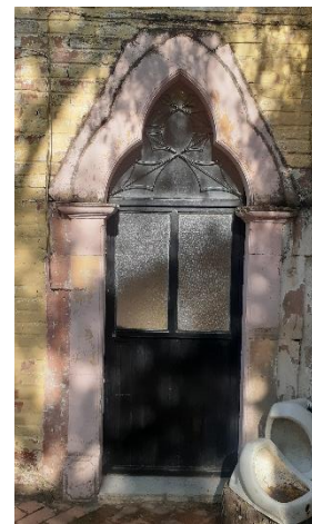
Ilustración 156 Arco ojival trilobulado en el acceso a la letrina. | Elaboración propia. 2022.
