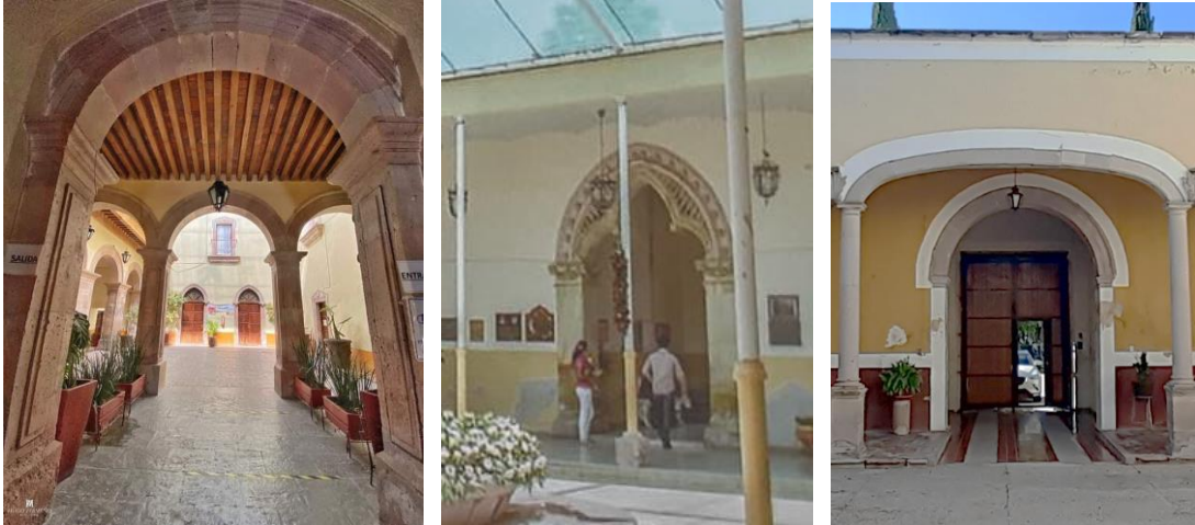
Ilustración 199 Constante en la selección de elementos constructivos en el zaguán. Arcos del zaguán hacia el patio y vano con dintel desde el acceso principal hacia el zaguán. | Elaboración propia. 2022.
