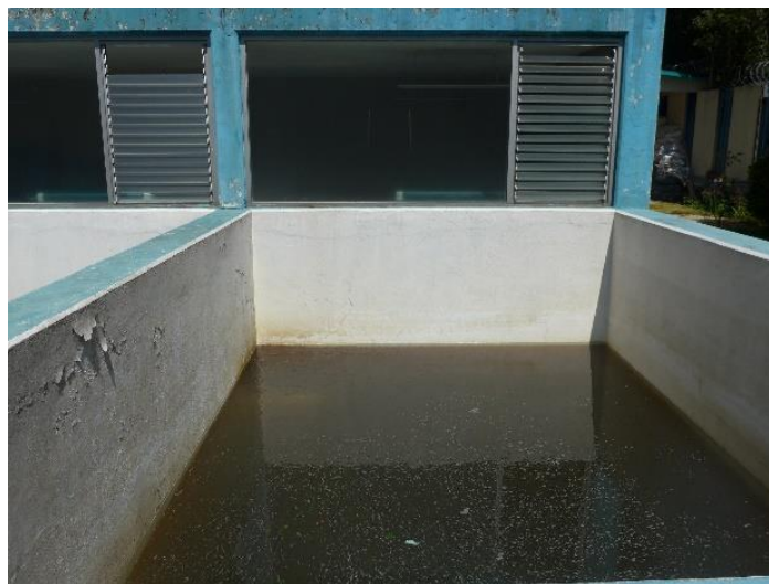
Figura 3.10 Filtros rápidos abiertos a la atmósfera.
