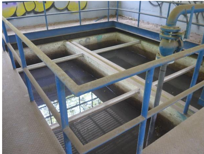
Figura 3.15 Sedimentador primario de alta tasa.
