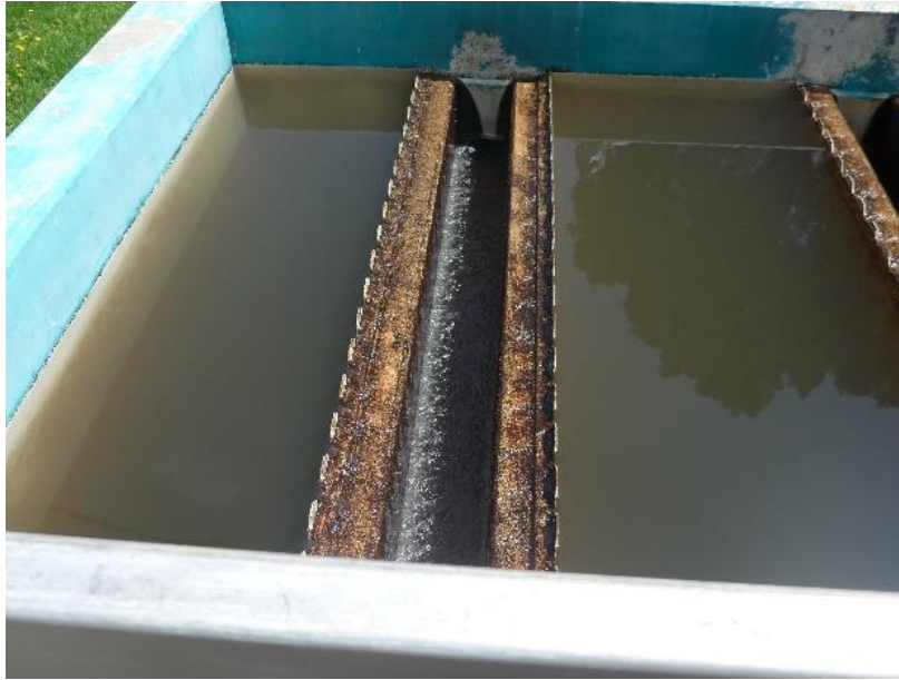
Figura 3.9 Cámaras de sedimentación.
