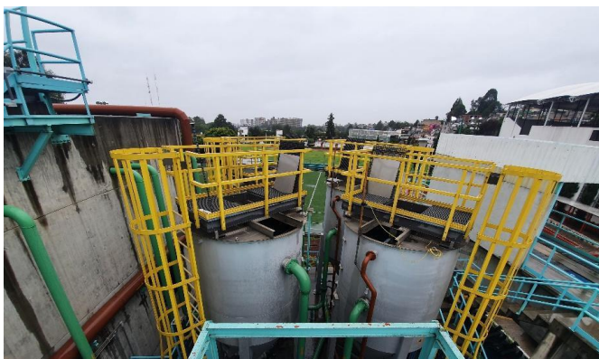
Figura 3.26 Filtros de flujo descendente con cama constituida por arena-sílica.
