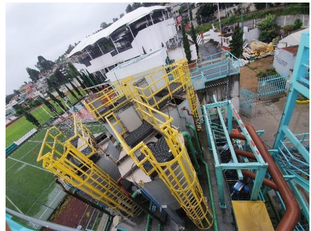
Figura 3.26 Filtros de flujo descendente con cama constituida por arena-sílica.
