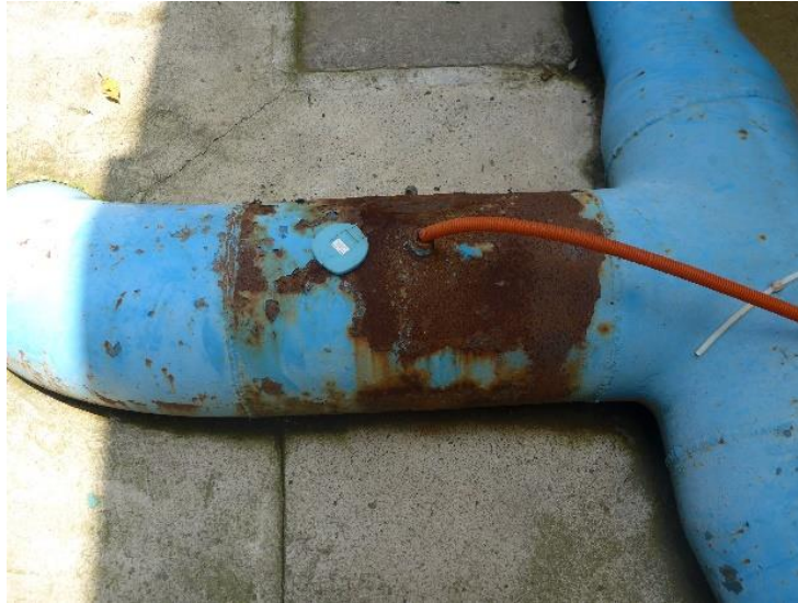
Figura 3.19 Punto de dosificación de hipoclorito de sodio.
