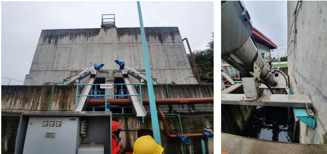
Figura 3.23 Microtamizadores rotatorios.
