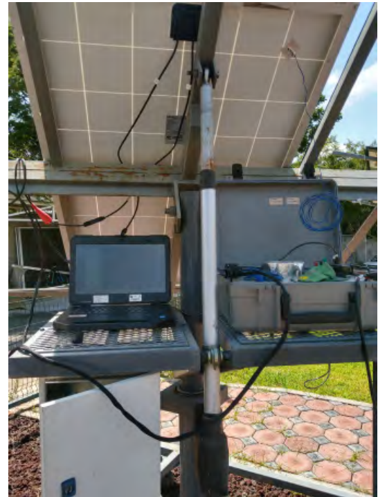
(b) MFV por la parte posterior con la conexión de cuatro hilos al trazador de curvas I-V, y termopares tipo T .
