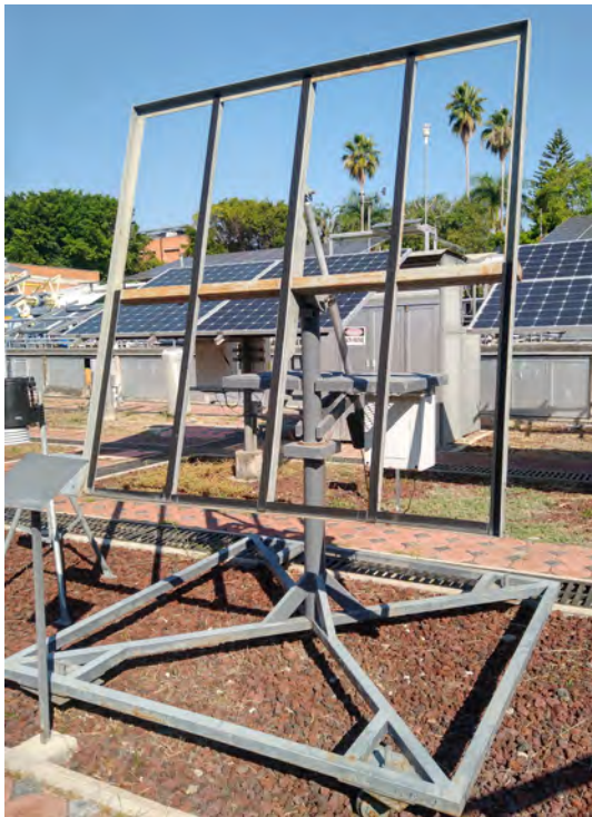
(a) Estructura de soporte de dos ejes
