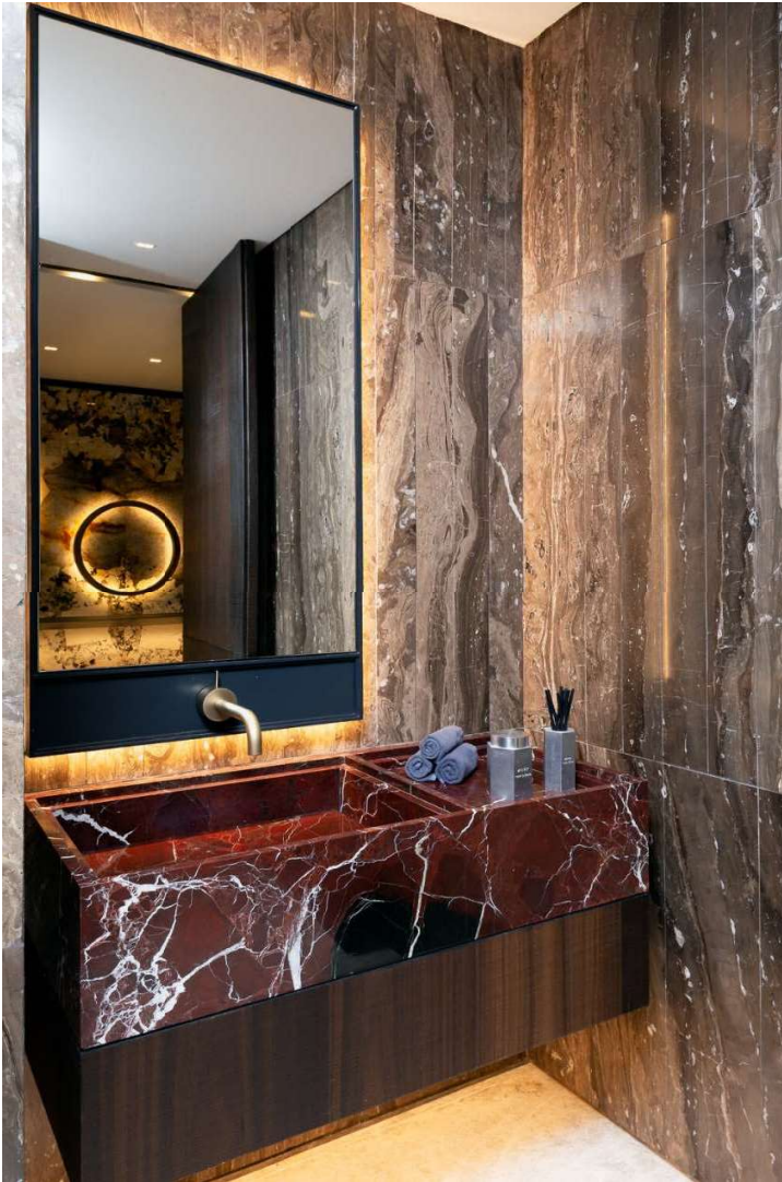
Figura 4.45. Proceso constructivo de baño de visitas. Se cuidaron las líneas del despiece de las modulaciones del cuarzo cappuccino, lavabo de mármol rojo levanto. Antepecho de madera de eucalipto ahumado y espejo de marco de placa de acero de 1/4" hecho en sitio.
