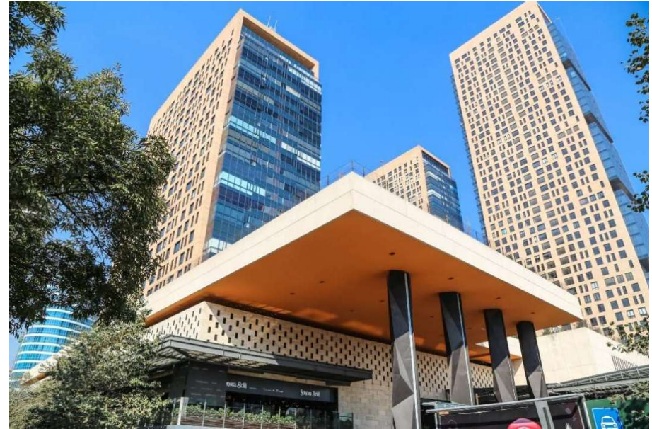
Figura 4.48 Miyana / Categoría Edificación. Arquitecto: Legorreta + Legorreta y Arquitech / Construcción GAYA.
