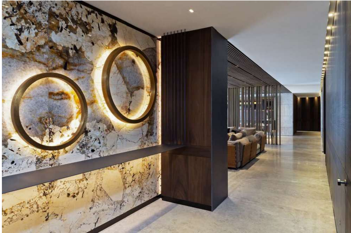
Figura 4.39. Proyecto P404. Vista Vestibulo. Muro de granito Patagonia, Luminarias Henge. Repisa de base placa de acero \frac{1}{4} sostenido por redondos de metal de \frac{3}{8} en tono natural. Zoclos metálicos en tono negro.
