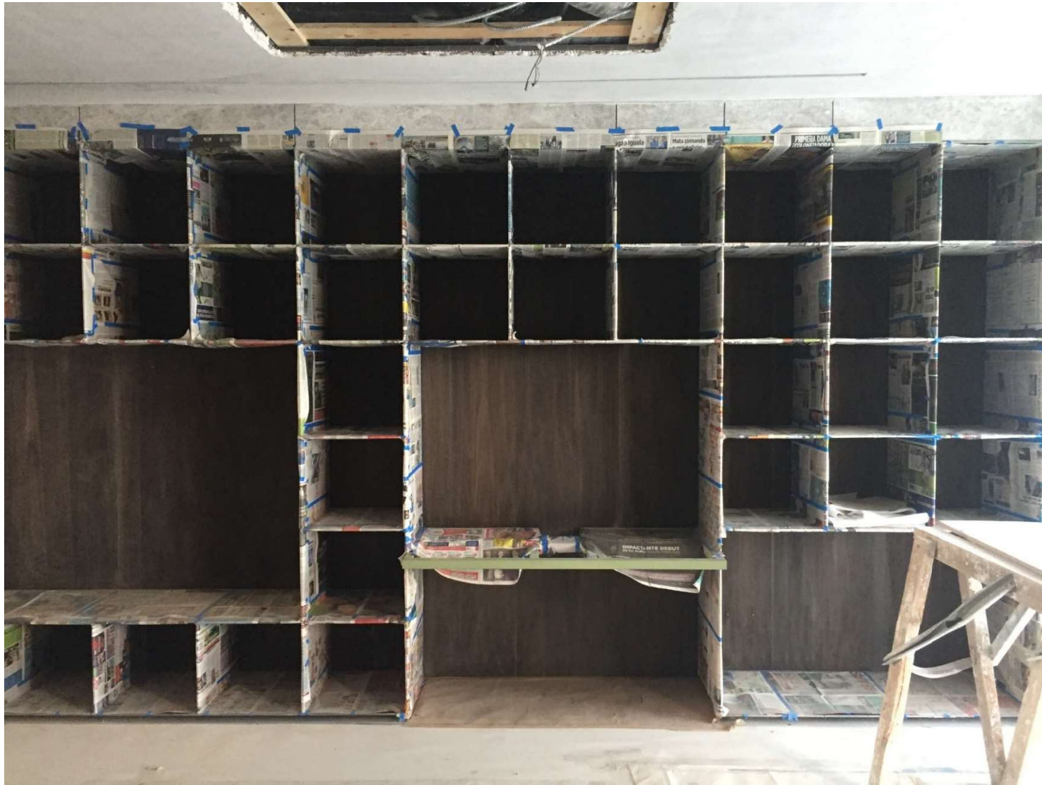
Figura 4.47 Proceso constructivo de mueble Family Room
