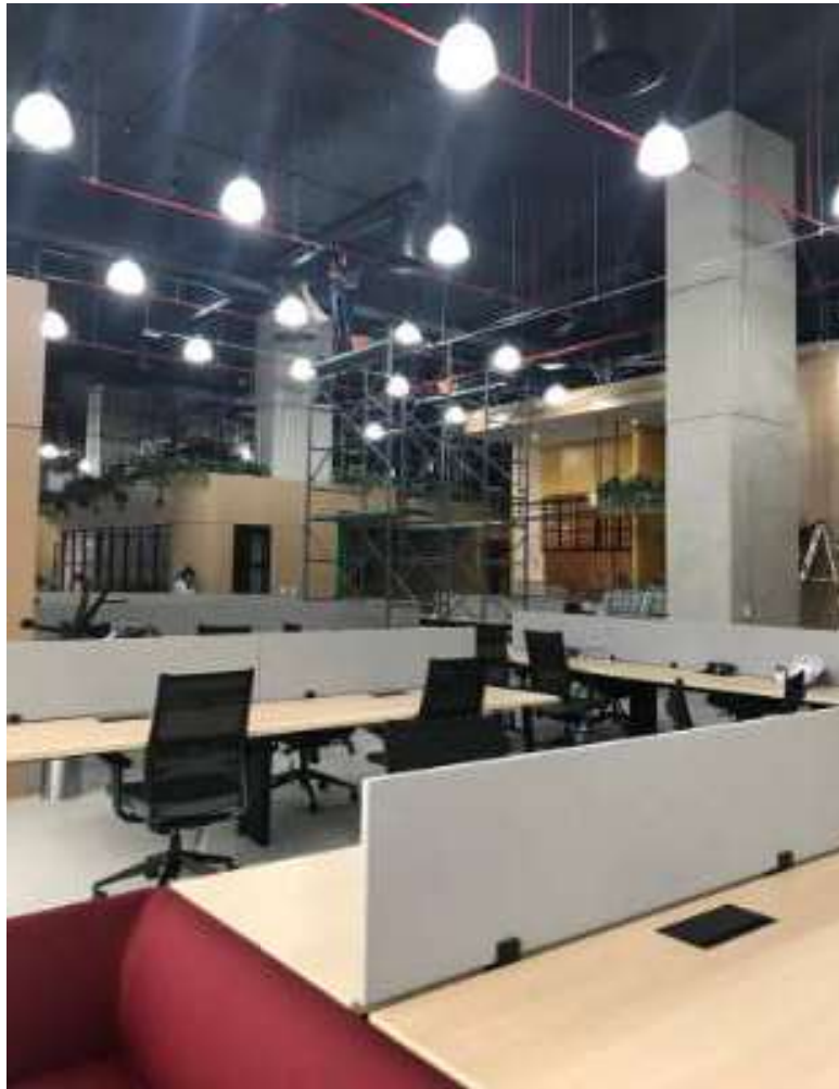
Figura 5.15 Trabajos durante la entrega sustancial en area abierta.
