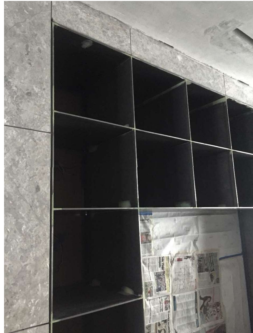
Figura 4.43 Detalles en la ejecución en sitio de mueble librero, Entrepaños de placas de acero soldadas para posteriormente ser pintadas in situ. Detalle de juntas de mármol biselado en muros.
