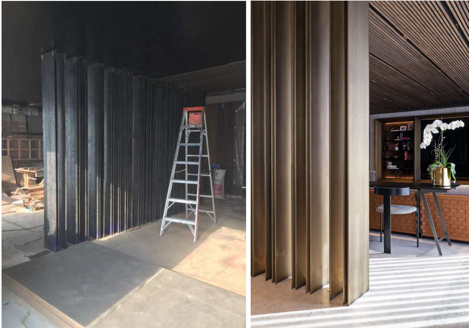
Figura 4.44. Proyecto P404. Proceso constructivo de celosías, las piezas hechas de placas de acero cold rolled de \frac{1}{4} , para posteriormente ser recubiertas del acabado latonado.
