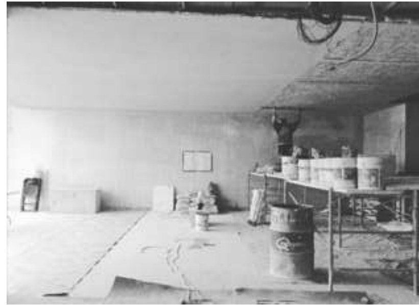
Figura 4.20 Proyecto Cumbres de Santa Fe. Etapa de albañilerías, armado de canaletas y malla galvanizada para falso plafón de yeso, aplanado de yeso en muros. Año 2015.
