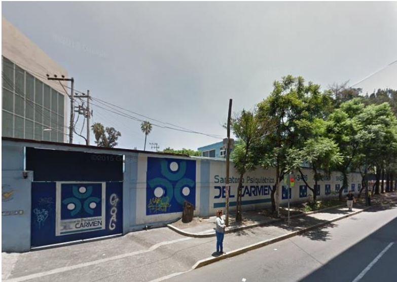
Fotografía 32. Sanatorio psiquiátrico del Carmen. cerrada notoriamente al exterior, en buenas condiciones y sin presencia de vandalismo.
