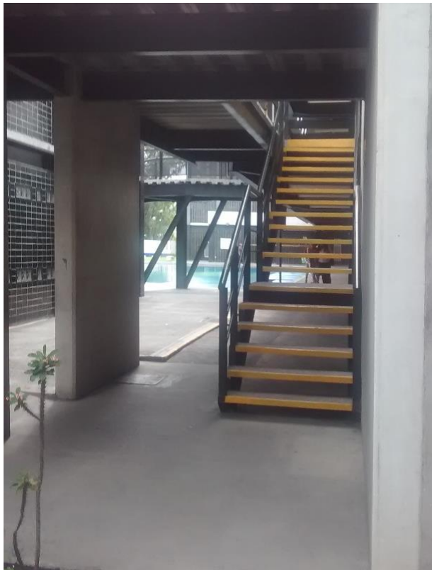
Fotografía 19. Vista de las escaleras que dan acceso a las aulas/taller y al taller de cómputo. de igual manera se aprecia que el sistema de entrepiso es losacero.
