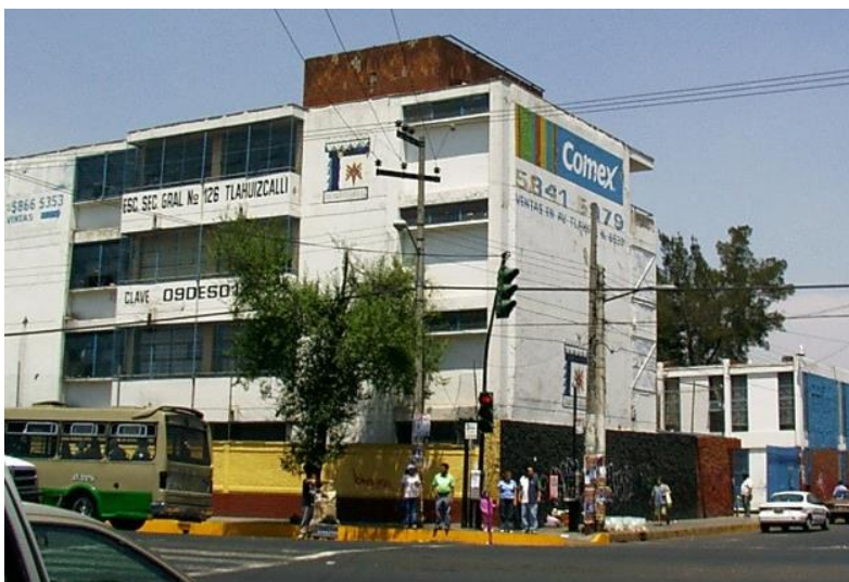
Fotografía 31. Escuela secundaria Diurna, se aprecia en buen estado, aunque cuenta con la presencia de vandalismo en sus delimitantes.
