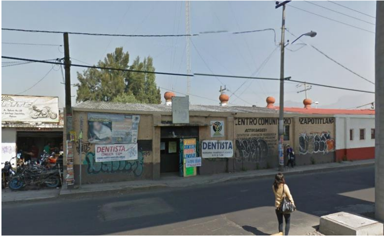
Fotografía 27. Centro comunitario Zapotitlán, ubicado en avenida Tláhuac sin número, colonia Santiago Zapotitlán. Presenta un alto grado de vandalismo en sus fachadas, como un nulo carácter de diseño.
