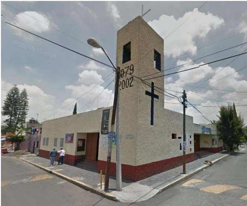
Fotografía 28. Parroquia del Sagrado corazón de Jesús, una construcción sencilla, pero con carácter propio. Sin vandalismo apreciable en sus exteriores.
