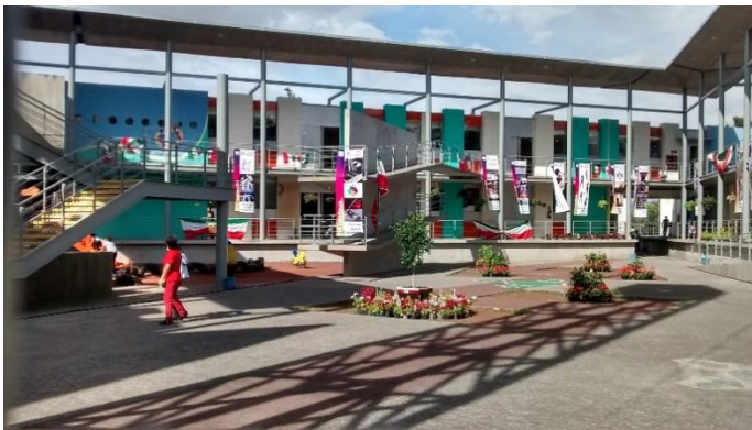
Fotografía 2. Vista del patio interior desde la plaza de acceso.
