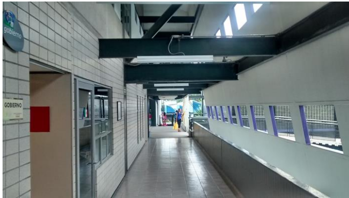
Fotografía 18. Vista de la circulación desde la zona de la administración.
