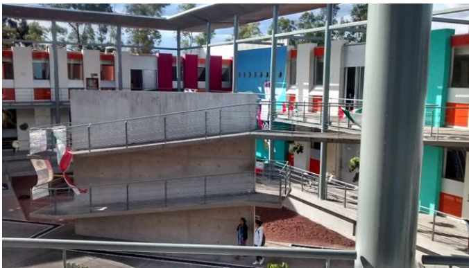
Fotografía 15. Vista de la rampa ubicada en el patio central del centro.
