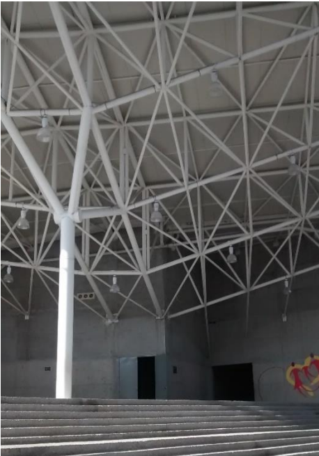
Fotografía 6. Vista del auditorio, destacando el diseño de la cubierta.
