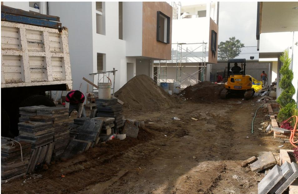
Imagen 58. Excavación de cepas para cambio de material en tuberías de instalación eléctrica en patio de circulación vehicular.
