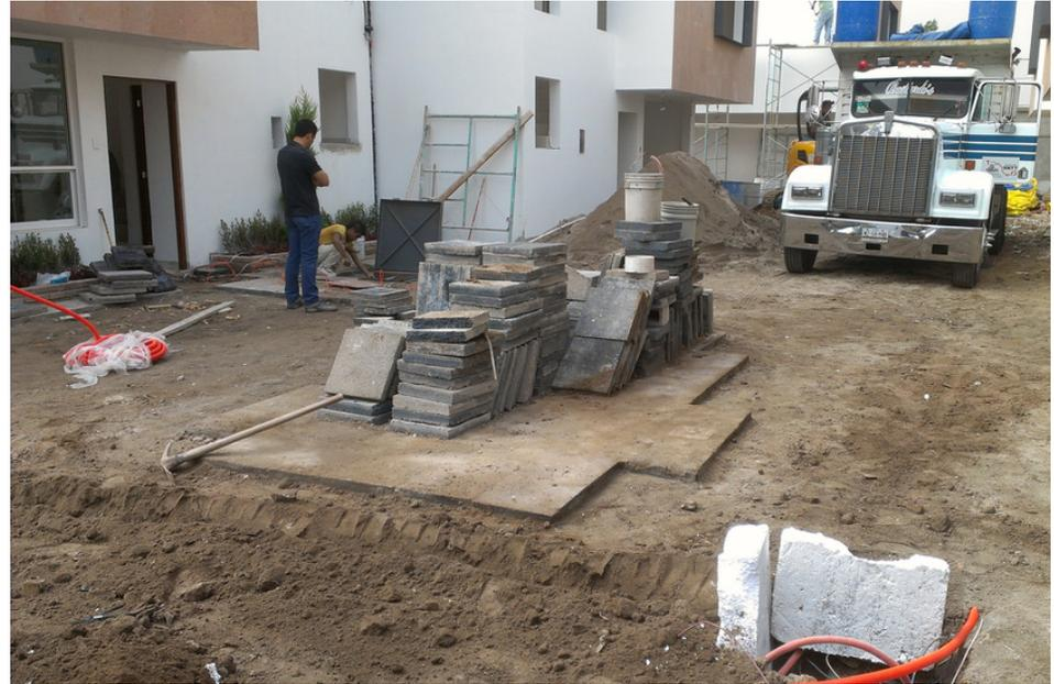
Imagen 57. Se levantó el recinto que ya estaba colocado para poder realizar los cambios solicitados y se utilizó mini excavadora JCB 280 para maniobrar en espacios reducidos.
