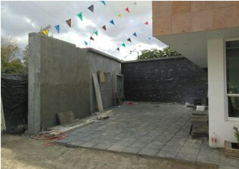
Imagen 38. Recinto en formato 40x40 cm en estacionamiento, que previamente estaba pensado como jardín para ampliar el área permeable, sin embargo, se modificó por petición del cliente.
