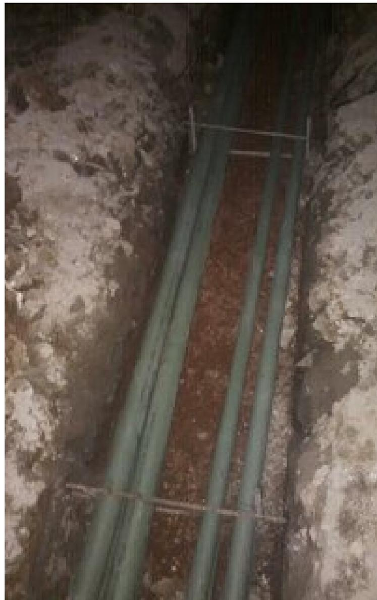
Imagen 59. Se utilizó tubería de PVC para los cambios solicitados por CFE.
