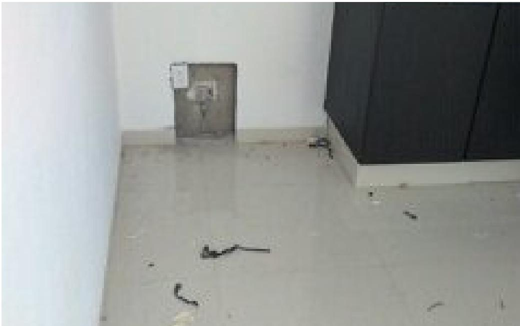
Imagen 42. Se dejó un nicho para no quitar espacio en área de refrigerador para conexión de agua con filtro para dispensador de refrigerador.
