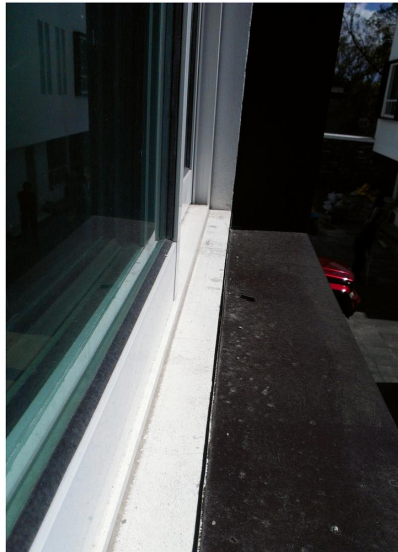
Imagen 55. Perfiles de aluminio agregados en perímetro de vano para ventanas en recámaras de Primer Nivel.
