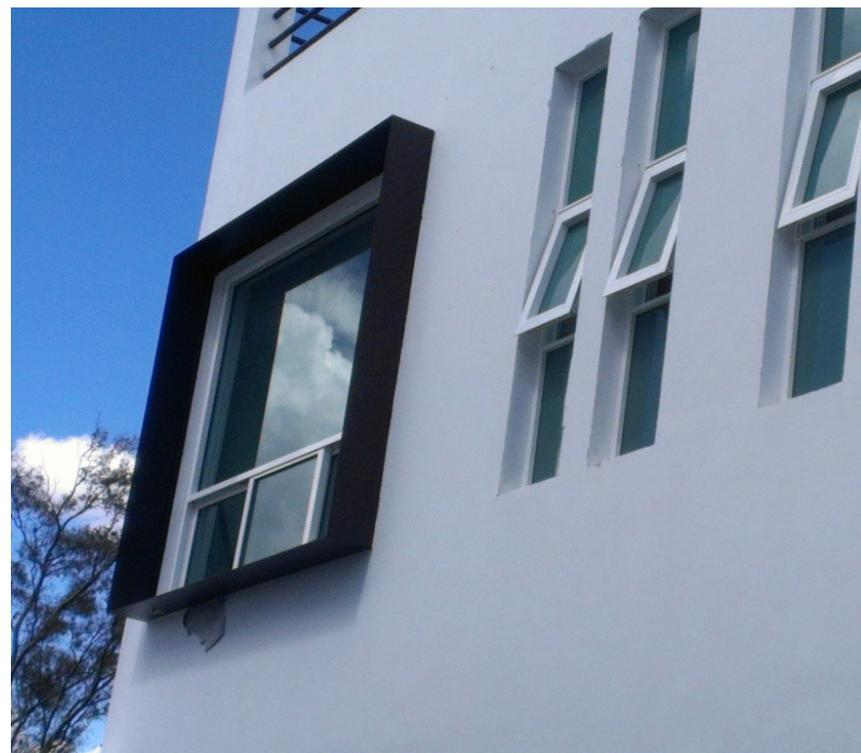
Imagen 53. Perfiles agregados alrededor de vano para ventanas en recámaras de Primer Nivel.
