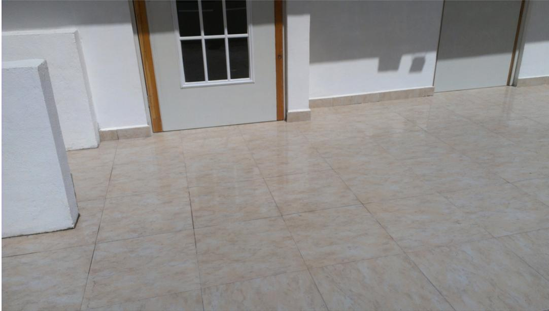
Imagen 39. Piso cerámico marmoleado para exteriores en Planta de Azotea/Roof Garden en formato de 33x33 cm. Posteriormente, se llegó a la conclusión de que se debió considerar otro piso con la característica de ser antiderrapante, pero no se hizo el cambio por presupuesto.
