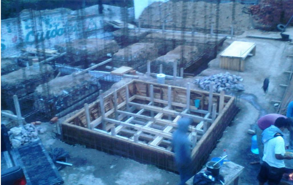
Imagen 5. Cimbrado para colado de contratrabes y armado de columnas. Se debe corroborar el amarre de la cimbra puesto que al colar, puede que la presión del concreto bote la cimbra, causando una pérdida fuerte de concreto, y por consiguiente, de dinero.
