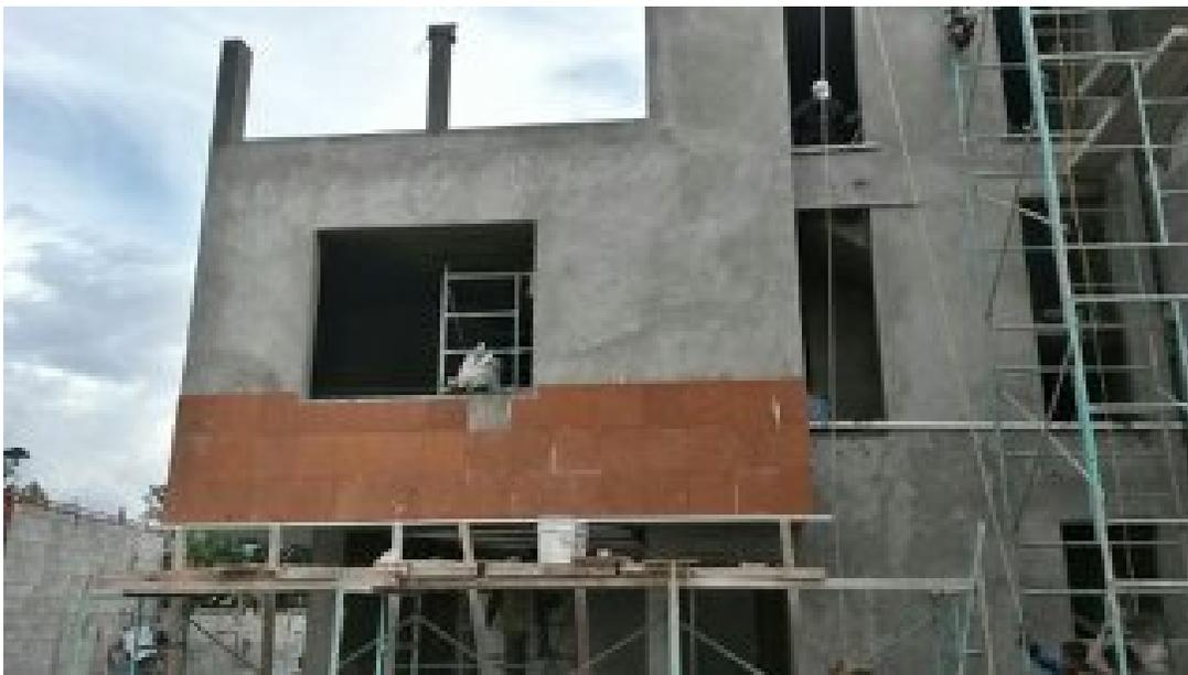
Imagen 18. Colocación de Ticul en fachada principal.
