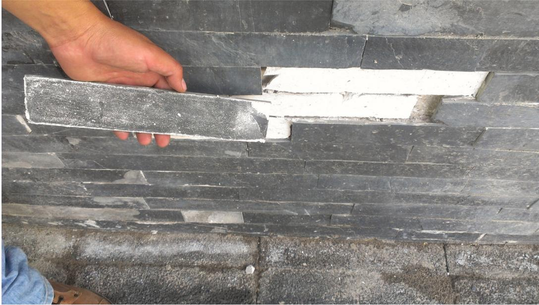
Imagen 49. Colocación de pedrín en muros de colindancia entre casas, con el fin de crear muros llorones que finalmente no se llevaron a cabo, pero se mantuvo el pedrín.
