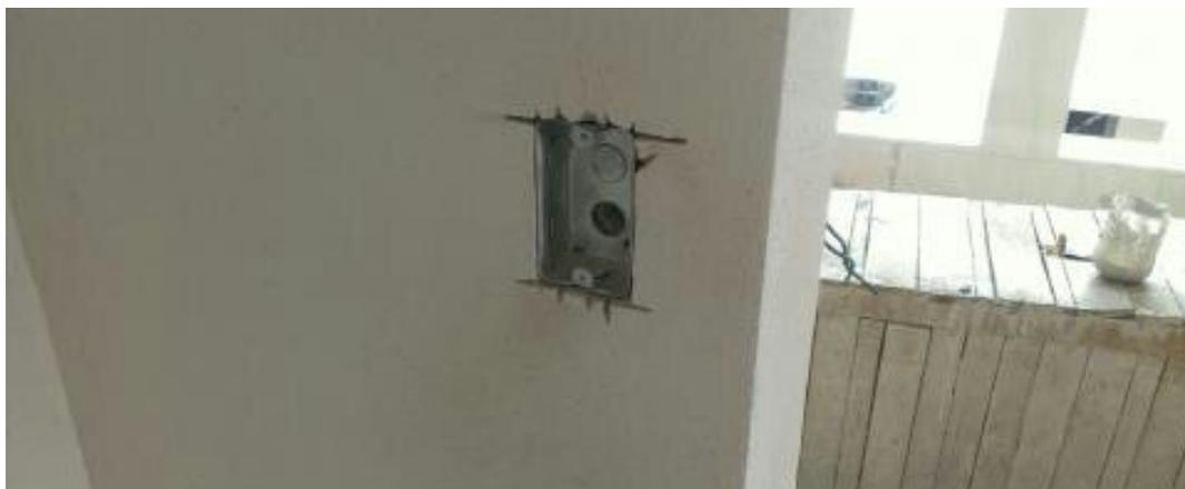
Todos los apagadores se colocaron a una altura de 1.20 m sobre nivel de piso terminado para fácil acceso.
