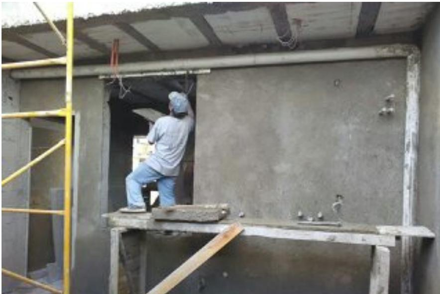
Instalación sanitaria con tubo de PVC de 4" con una pendiente de 2% para conectarse con un registro y posteriormente, al albañal, que es el canal por el cual se conducen las aguas residuales hacia el exterior del predio.
