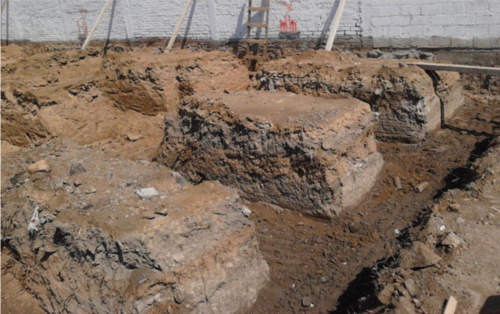
Imagen 3. Excavación de cepas para armado de zapatas corridas. Al inicio se utilizó retroexcavadora pero debido a la dureza del suelo, se optó por cambiarla por una excavadora hidráulica CAT 320 con el fin de acelerar el proceso y no retrasar tiempos.
