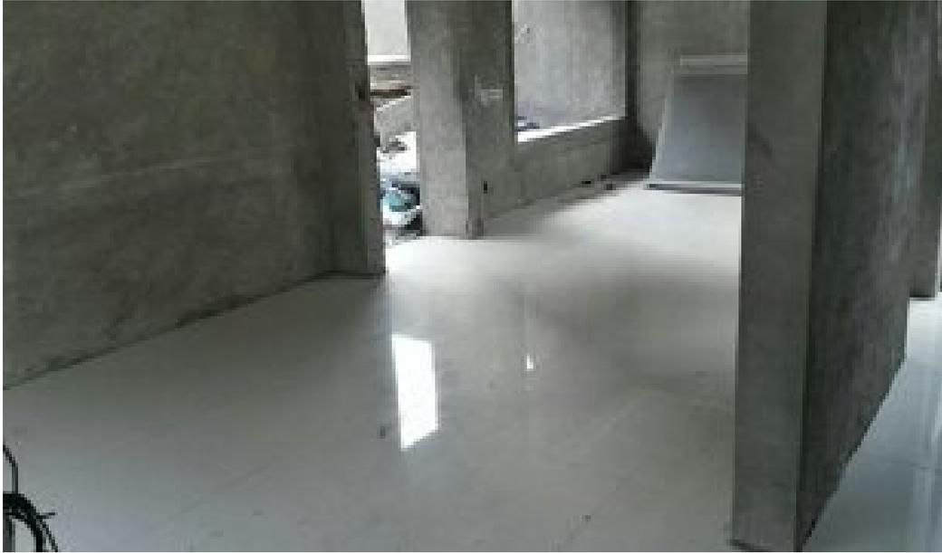
Imagen 41. Se optó por piso cerámico pues tiene una vida útil larga, por su fácil instalación y su bajo mantenimiento. Para este proyecto se utilizó piso cerámico en formato 50x50 cm.
