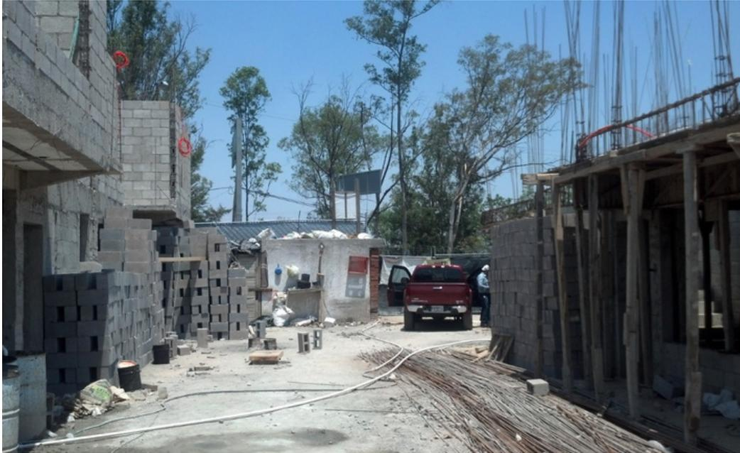
El proceso de armado, levantamiento de muros y colado, se hizo simultáneamente en todas las casas por nivel. Es decir, al momento de colar Planta Baja, por ejemplo, se coló en las 6 casas y así sucesivamente verticalmente.
