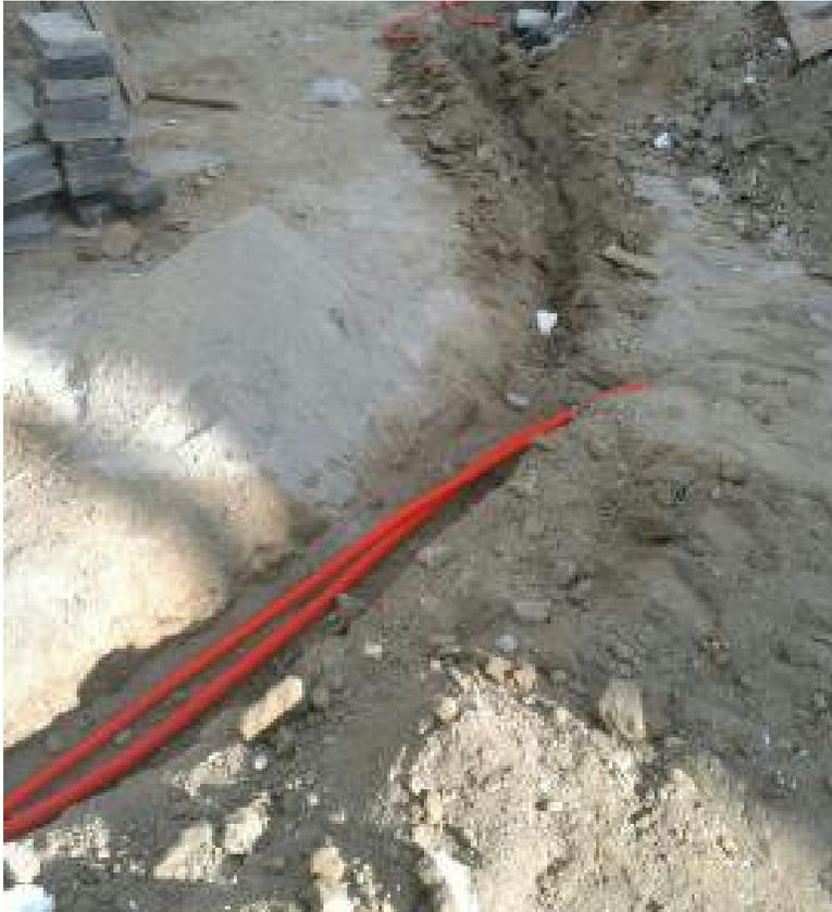
Imagen 56. Poliflex no fue aceptado por CFE para el recorrido de instalación eléctrica por lo que se cambió.
