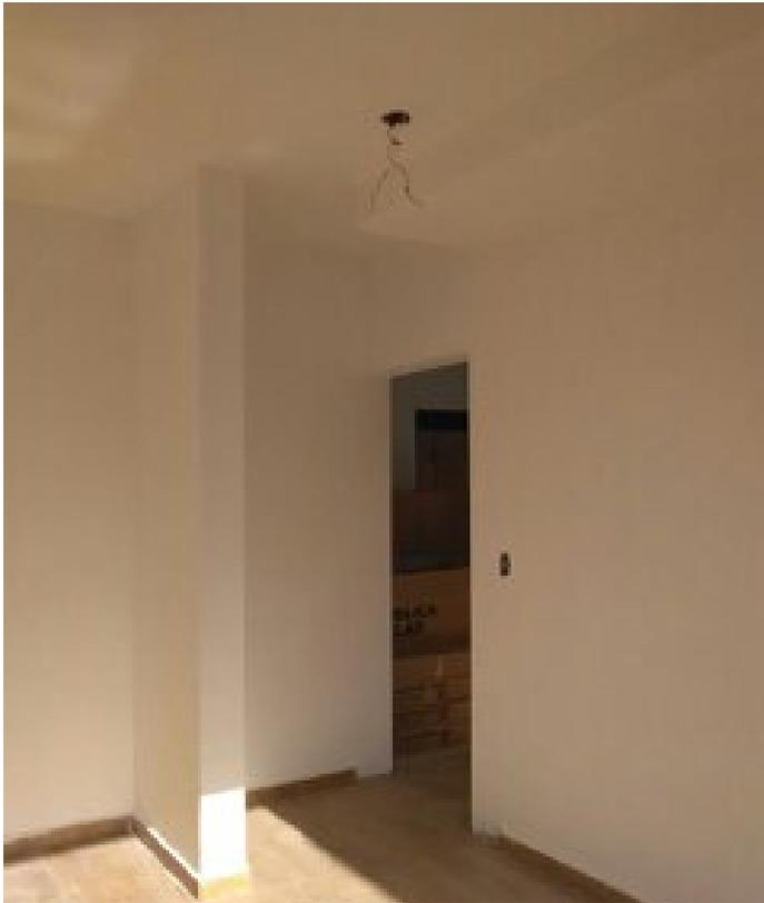
Imagen 45. Todos los muros y plafones interiores fueron repellados y aplanados con yeso para posteriormente pintarse con pintura vinílica blanca.
