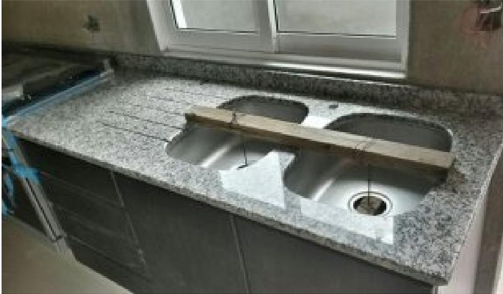
Imagen 43 . Cubierta para fregadero de granito blanco Kashemere. Se optó por este material ya que da una imagen realza los acabados de manera considerable en cocina.
