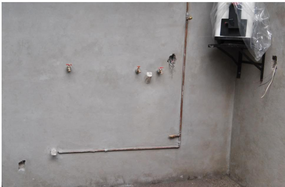
Imagen 34. Salida para calentador en P.B.
