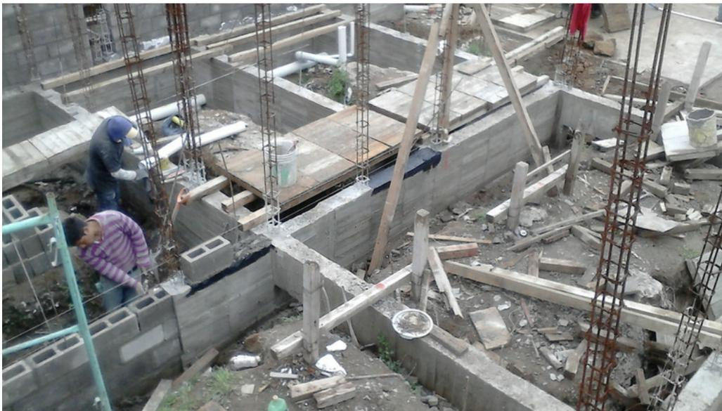
Imagen 6. Contratrabes descimbradas. Armado de cadena de desplante para muro de carga en Planta Baja. Así como castillos.
