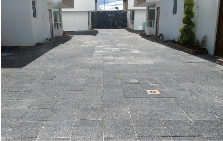
Imagen 37. Se instaló recinto 40x40 cm con 2 cm de espesor en circulación vehicular. Esta piedra natural da un gran aspecto visual al área, y de igual manera, resalta los colores utilizados en la fachada de cada casa.
