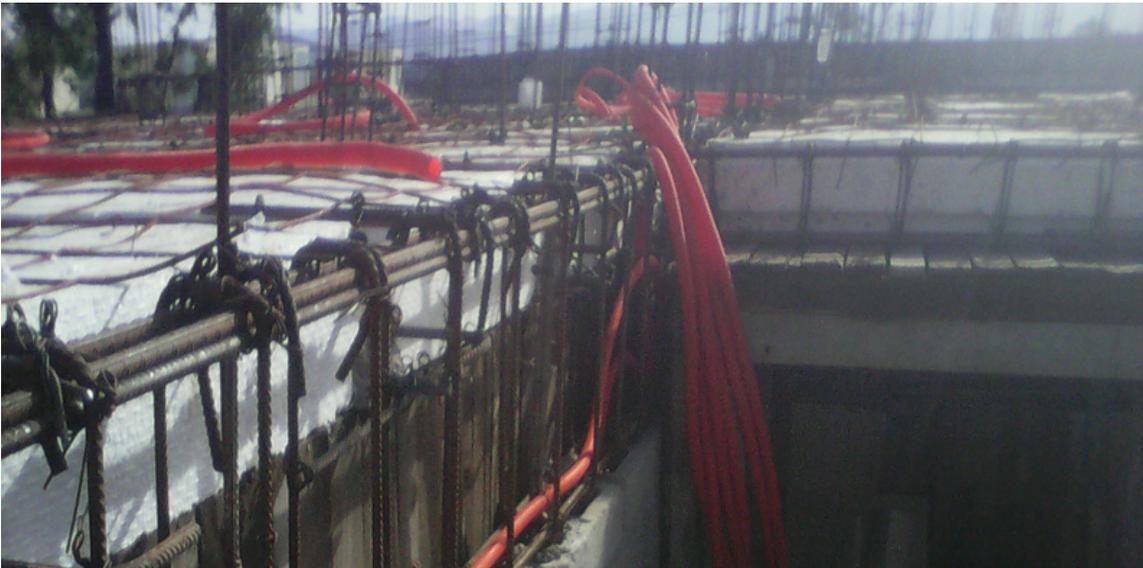
Imagen 13. Armado de losa de Primer Nivel para encachetar losa.
