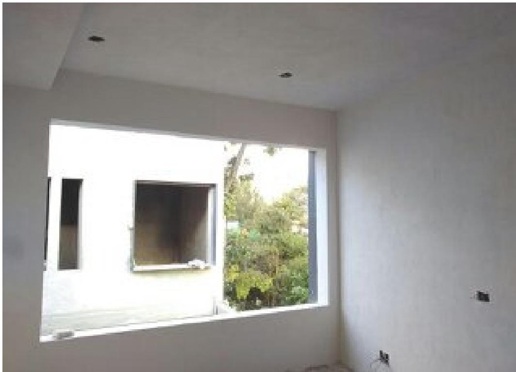
Se instalaron 2 contactos polarizados dobles por salida, al igual que apagadores sencillos y uno de tres vías para prendido y apagado desde dos puntos distintos en la habitación.
