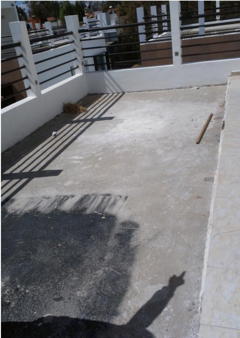
Imagen 21. Cambio de uso en azotea por requerimiento de cliente, reforzando la losa y preparándola para colocación de pasto tipo Kikuyo.
