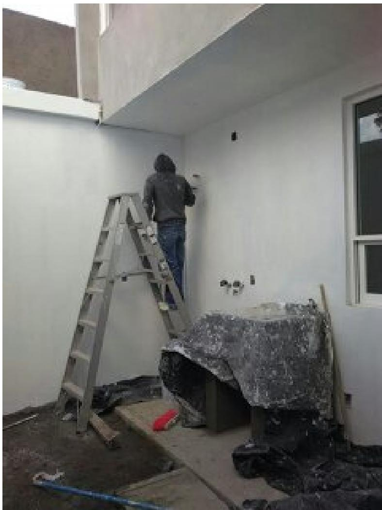
Imagen 35. Preparación de salida para calentador.
