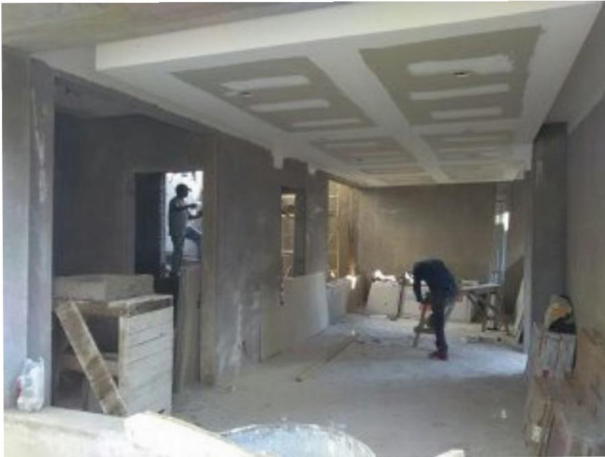
Colocación de tablaroca en interiores y perfacinta, hecha de papel áspero de 5 cm de ancho, para reforzar uniones y evitar que se agriete, mejorando su rendimiento.
