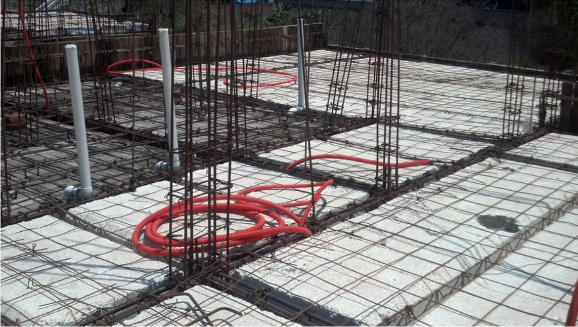
Para el colado de la capa de compresión sobre la bovedilla, se dejaron todos los botes de luz e instalaciones sanitarias, ubicadas entre viguetas y bovedilla que pasan por plafón.
