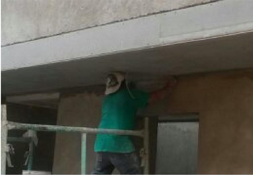
Se colocó Durock en exteriores por estar hecho de cemento laminado con una malla de fibra de vidrio polimerizada en ambas caras, es decir, resistente al agua y al deterioro causado por condiciones climáticas.
