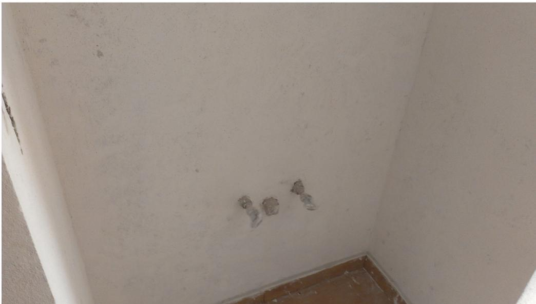
Se dejaron llaves de paso en instalación hidráulica para control del agua potable.
