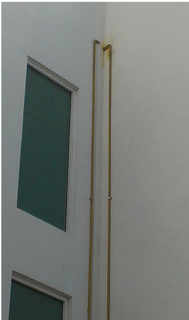
Imagen 33. Instalación de gas en fachada.
