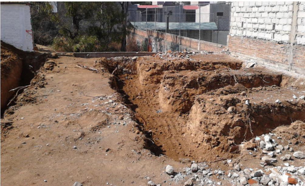
Imagen 4. Excavación para armado de zapatas corridas y contratrabes.
