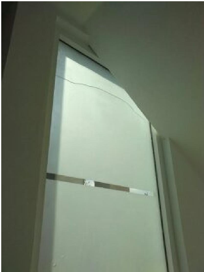
Imagen 54. Cristal roto por presión de marco de aluminio por falta de instalación de poliuretano.
