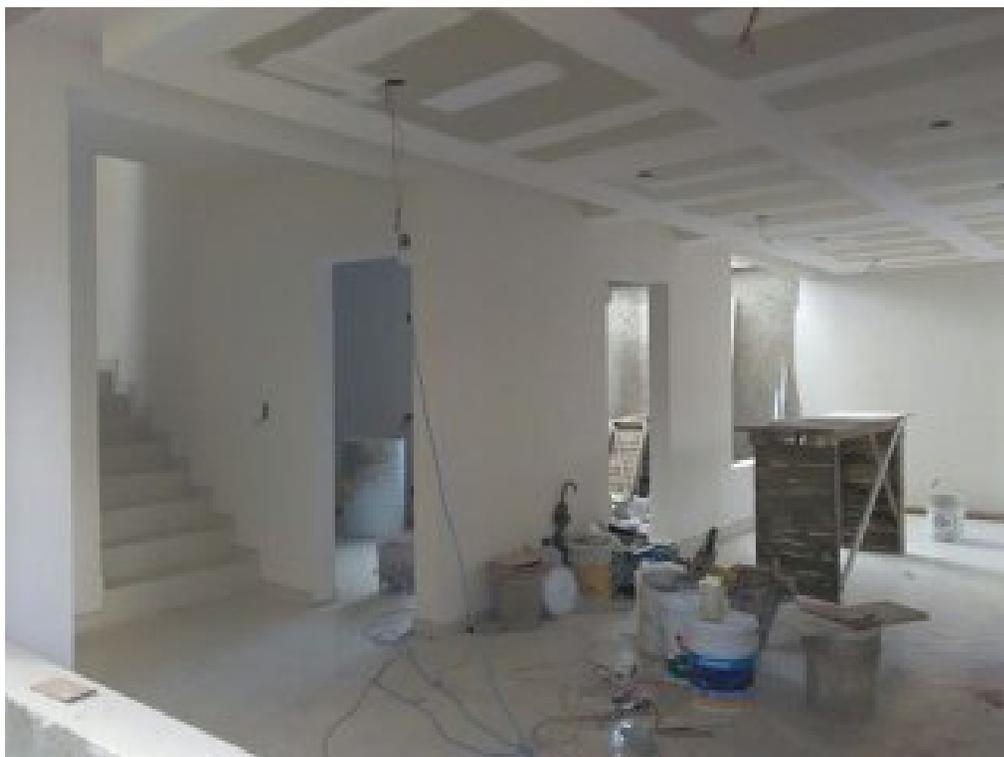
Imagen 23. Colocación de perfacinta, que es cinta de refuerzo para juntas en plafón de tablaroca para posteriormente colocar readymix y lijar para dejar acabado fino.
