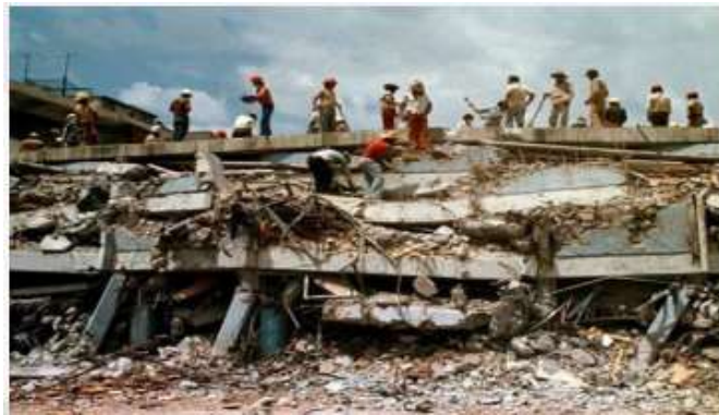
Figura 4.4 Vista del colapso de estructura de la Universidad de la Ibero (Ventura & Quinde, 2019).
