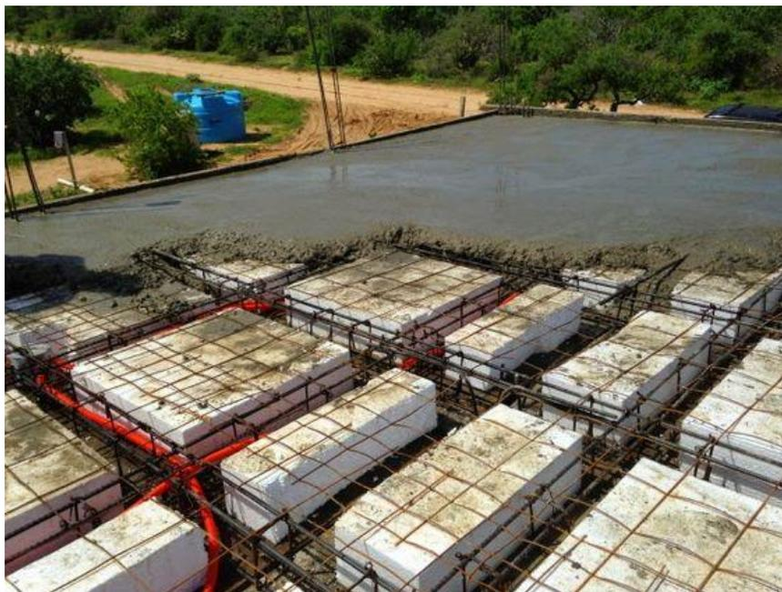
*Ilustración 36 Losa aligerada con nervaduras y bloques de poliestireno (reforzado, 2022)*
