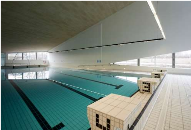
Imagen 30. Alberca de 25m Centro de rehabilitación Vandhalla.
