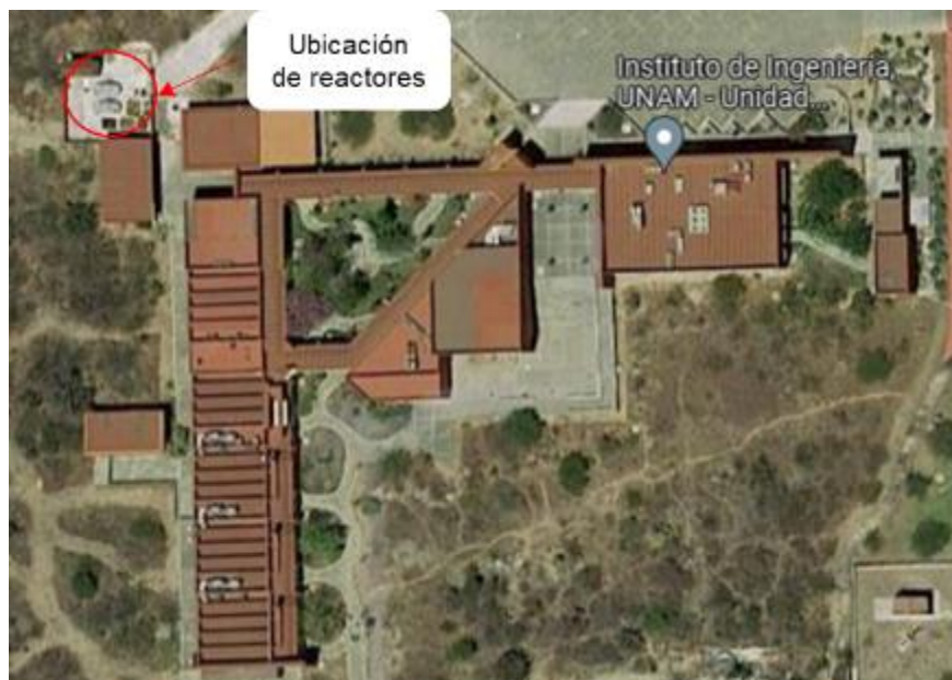
Figura 9. Ubicación de los reactores en el LIPATA
