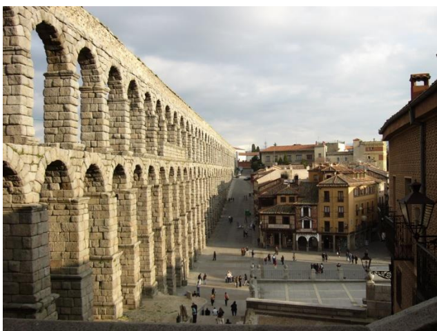
Ilustración 5 Acueducto de la época romana en Segovia, España (reproducción hecha con fines didácticos)
