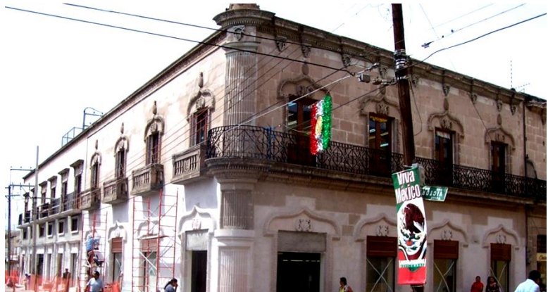
33 Edificio "Telas Parisina", la parte inferior fue reconstruida como parte del programa "Rescate del centro histórico" aquí se puede ver claramente la diferencia de tono entre la cantera nueva y la vieja, ambas procedentes del mismo banco. Foto Esdras Alvarez
