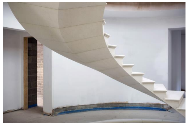
Ilustración 24 Escalera Elaborada con Marmol Postensado Desarrollada por Webb Yates Engineers y The Stonemasonry Company Fuente: Arch Daily Foto: Agnese Sanvito Reproducción hecha con fines didácticos
