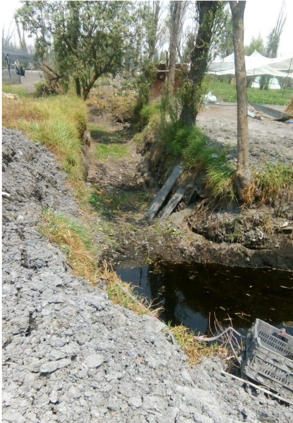
Canal seco (con zanja en construcción)
