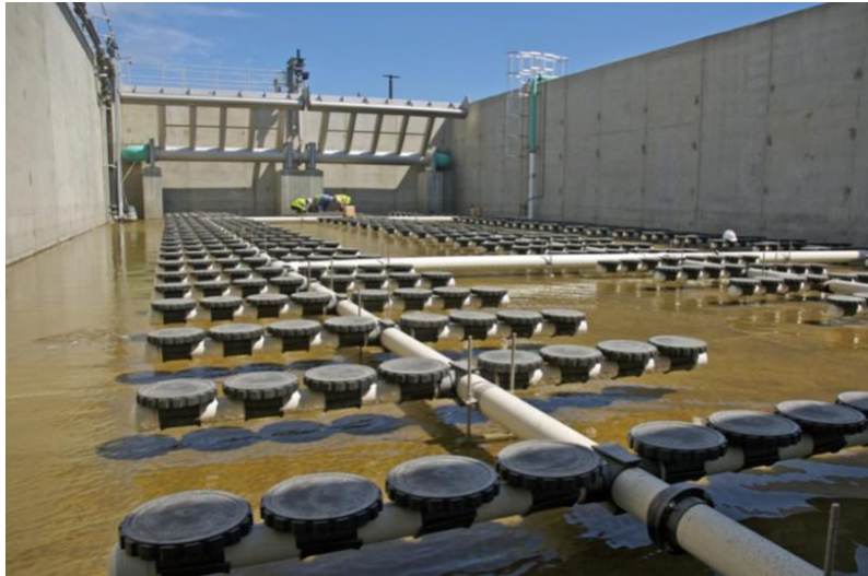
Imagen 3-4. Sistema sumergido de difusión de aire. 30
