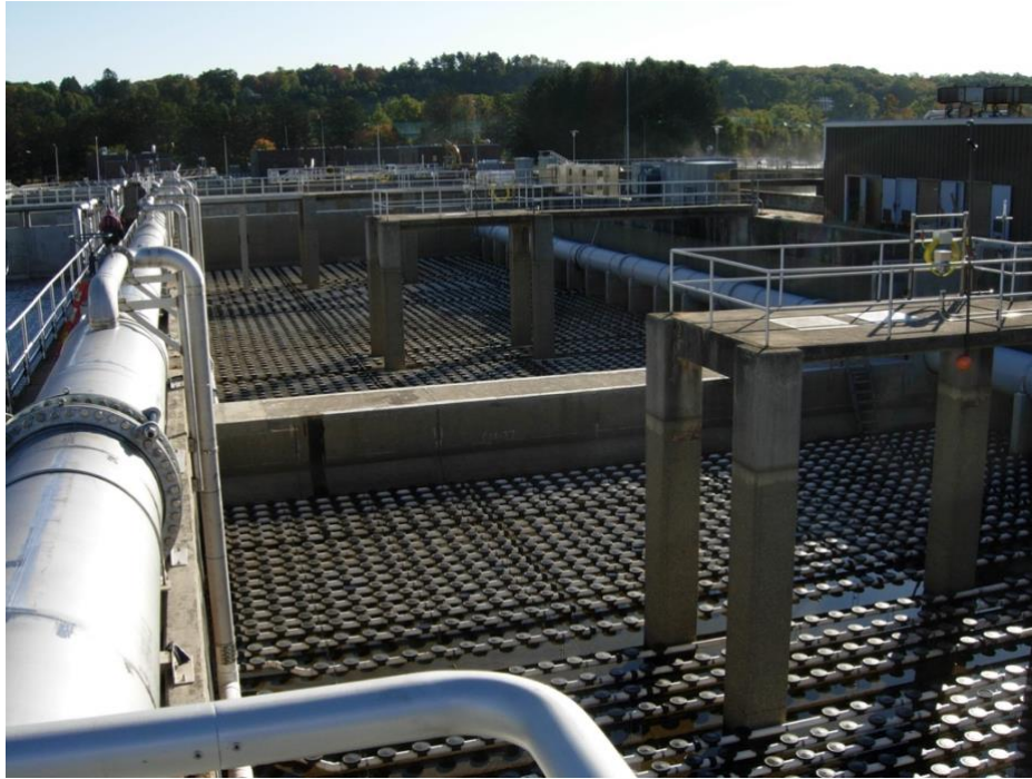
Imagen 1-4. Sistema de aireación en un proceso biológico. 12
