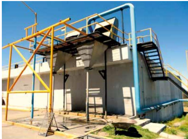
Imagen 3-1. Ejemplo de tratamiento primario. (Rejillas fijas para cribado) 16
