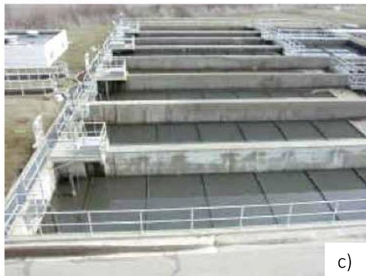
Imagen 3-2. Sedimentadores primarios a) Rastras b) Sedimentador circular c) Sedimentador rectangular d) Vertedores triangulares. 18
