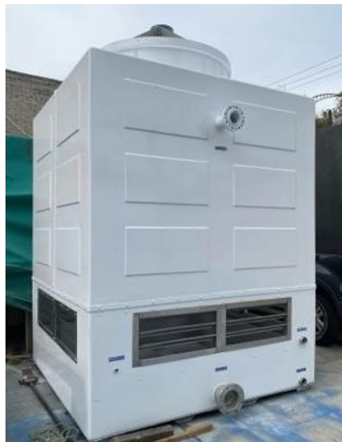
Figura 40. Torre de enfriamiento de tiro inducido.
