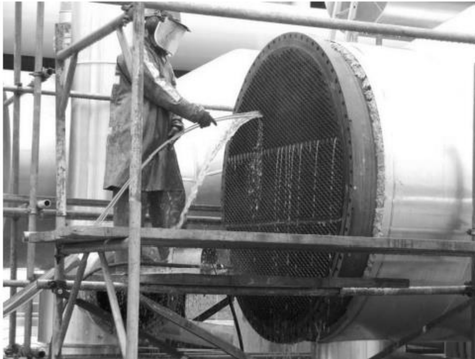
Figura 81. Limpieza de intercambiador de calor de tubos (Ibid, 457).
