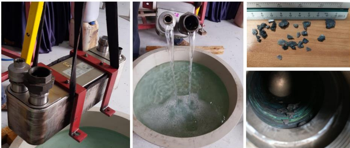
Figura 82. Mantenimiento de intercambiador de calor.
