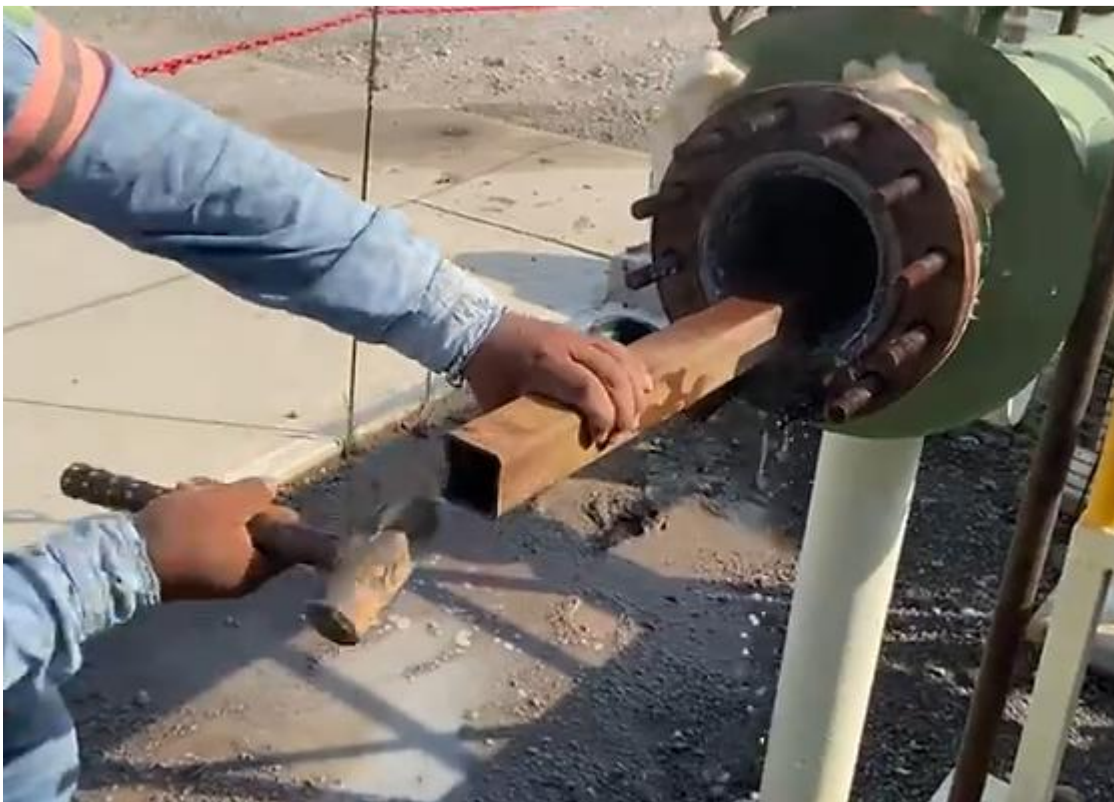
Figura 88. Retiro de incrustación en tubería.
