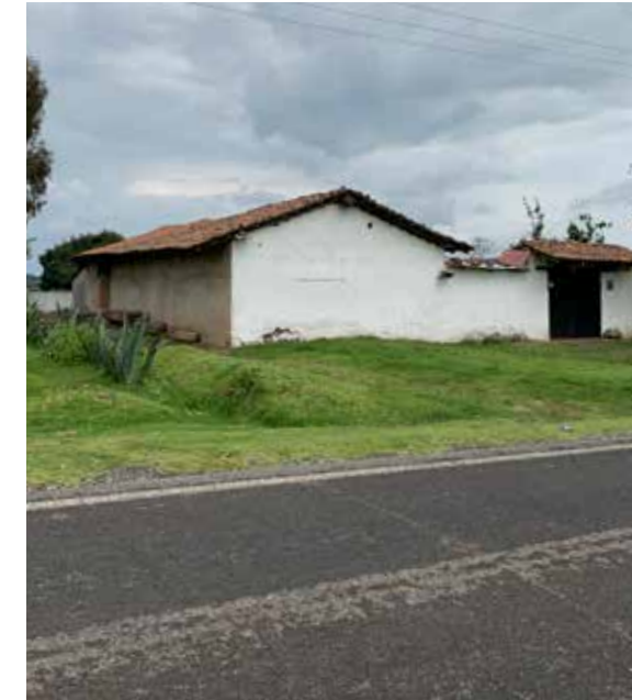
San F. del Progreso Techo de teja de barro Muros de adobe con aplanado de cal Cimentación de mampostería
