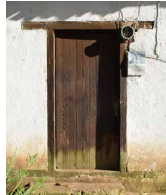
Fresno Nichi, San F. del Progreso Muros de adobe Cimentación de mampostería madera en estructura y carpintería
