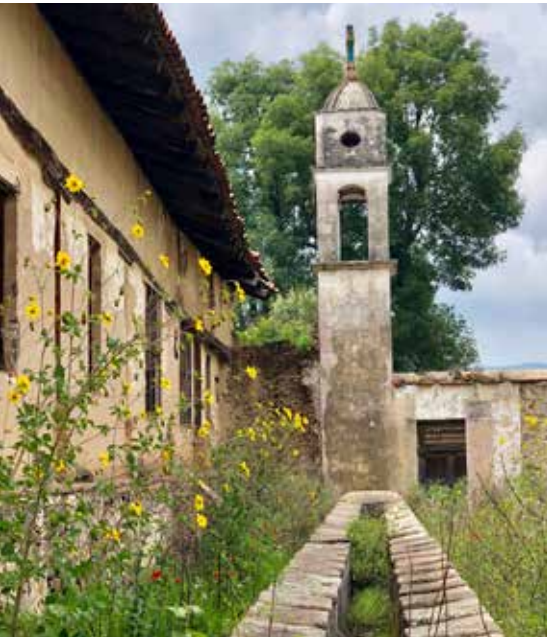
Chotejé, San F. del Progreso Techo de teja de barro Muros de adobe y piedra Cimentación de mampostería
