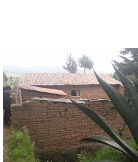
Chotejé, San F. del Progreso Techo de teja de barro Muros de adobe Cimentación de mampostería
