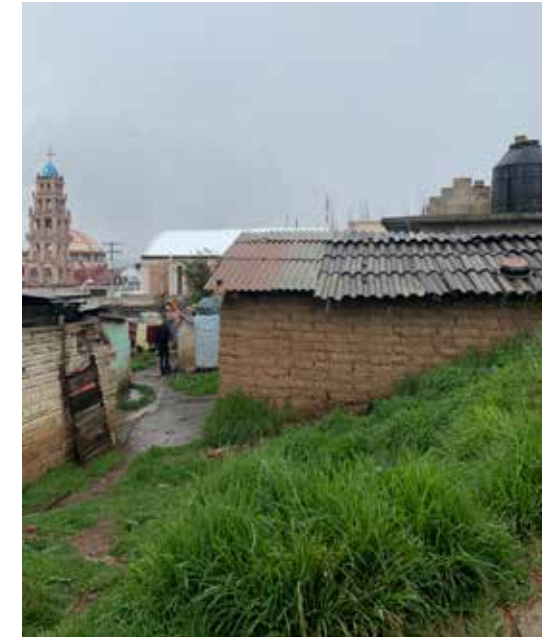
Fresno Nichi, San F. del Progreso Techo de lámina Muros de adobe Cimentación de mampostería
