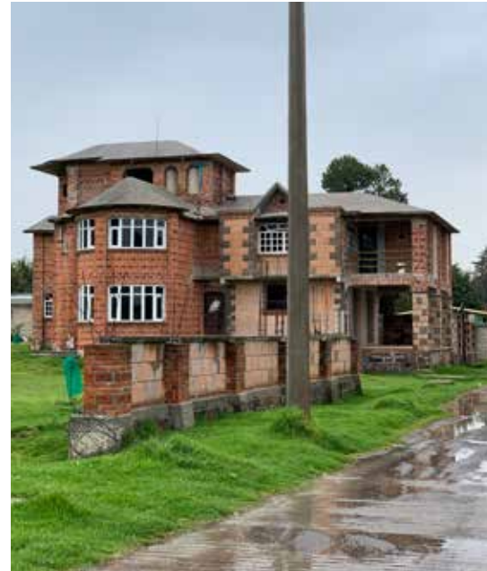
Fresno Nichi, San F. del Progreso Techo de concreto Muros de tabique rojo Cimentación de mampostería
