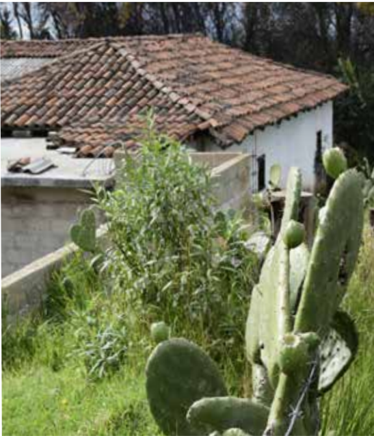
Fresno Nichi, San F. del Progreso Techo de teja de barro Muros de adobe Cimentación de mampostería
