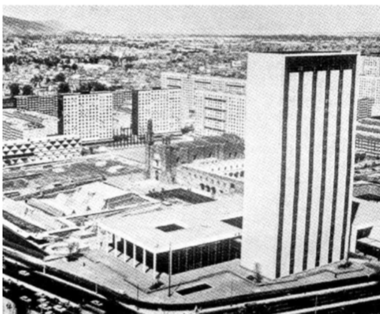
Imagen 2.11 “Vista aérea del Edificio para la Secretaría de Relaciones Exteriores” Arquitectura México , no. 100 (1968): 69
