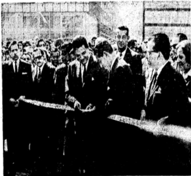
DONDE SE INICIA la prolongación del Paseo de la Reforma, el Presidente López Mateos, auxiliado por el regente Ernesto P. Uruchurtu, corta el listón que simbólicamente abrió al tránsito esa nueva arteria vital, en presencia de funcionarios del Departamento del Distrito Federal
