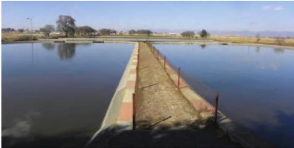
Figura 11. Laguna de Estabilización, PTAR de Santa María Rayón, México (Noyola *et al.*, 2013).
