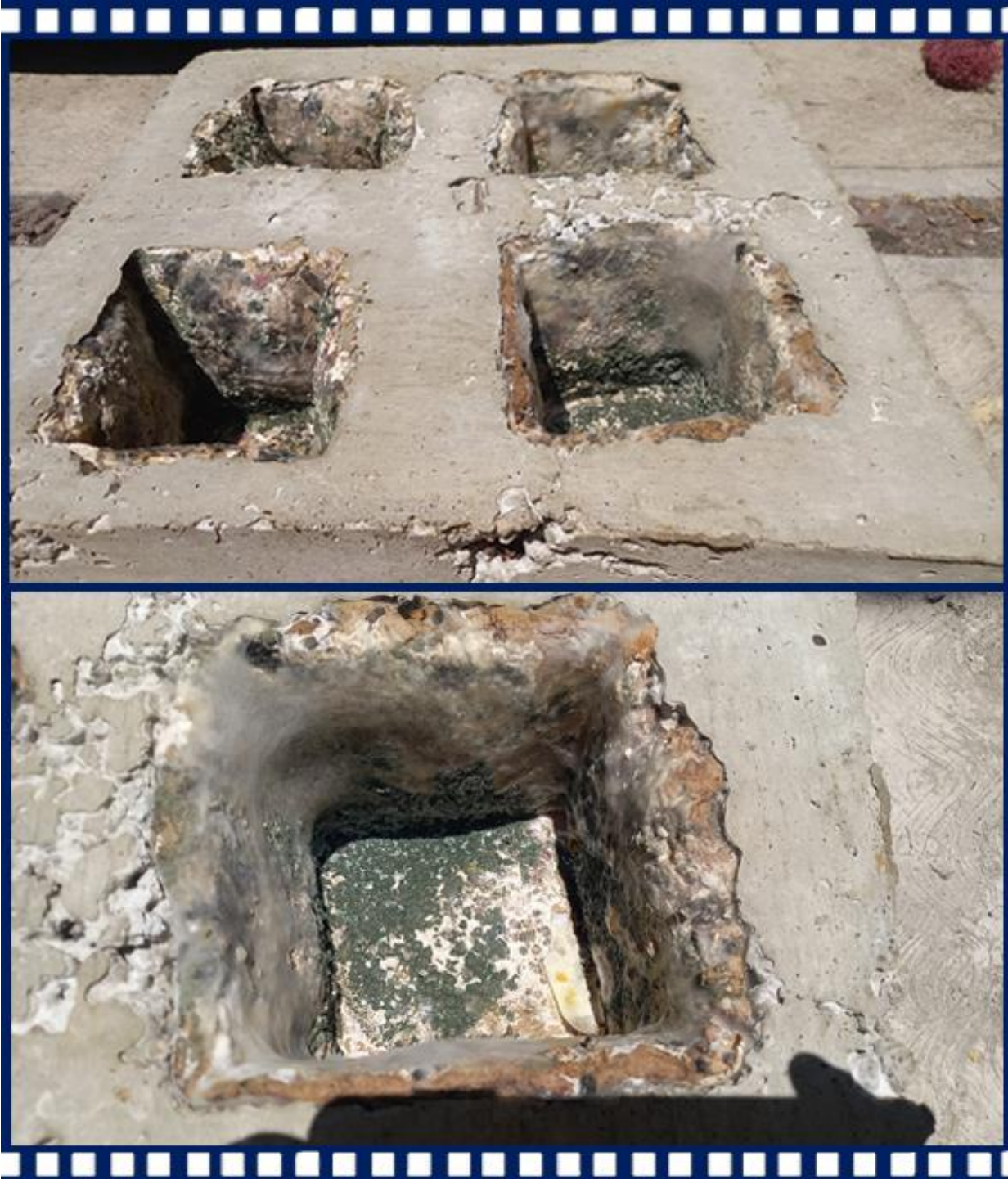
Ilustración 52. Descimbrado y revisión de funcionalidad del prototipo fabricado.
