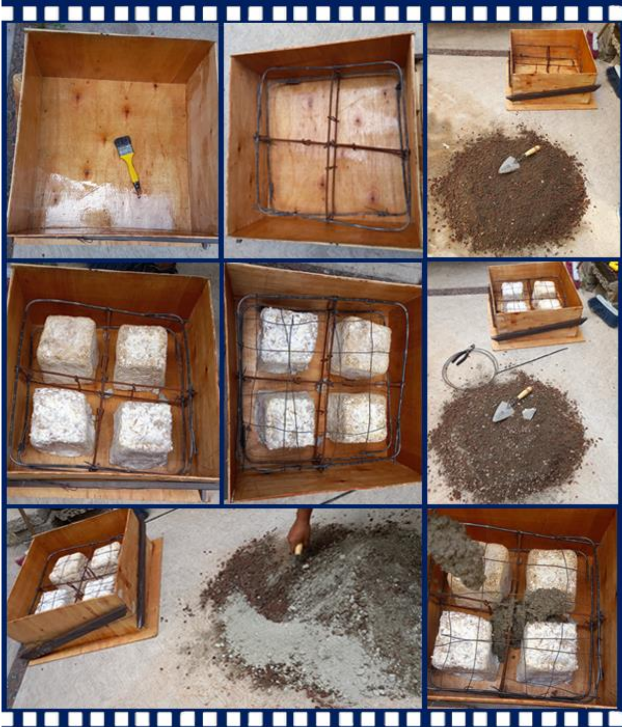
Ilustración 50. Proceso de preparación, armado y colado del sistema.
