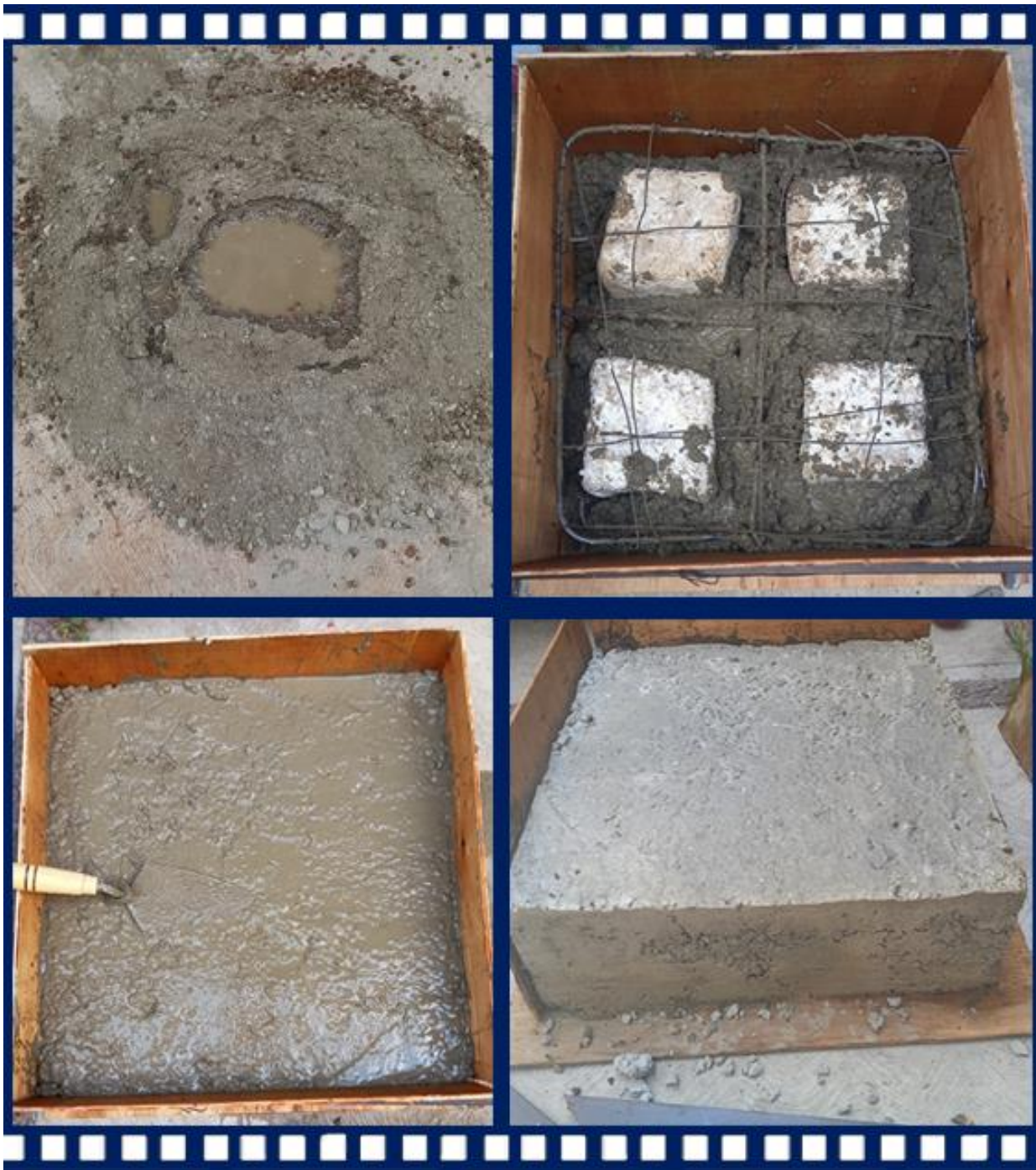
Ilustración 51. Proceso de colado y descimbrado de fronteras.
