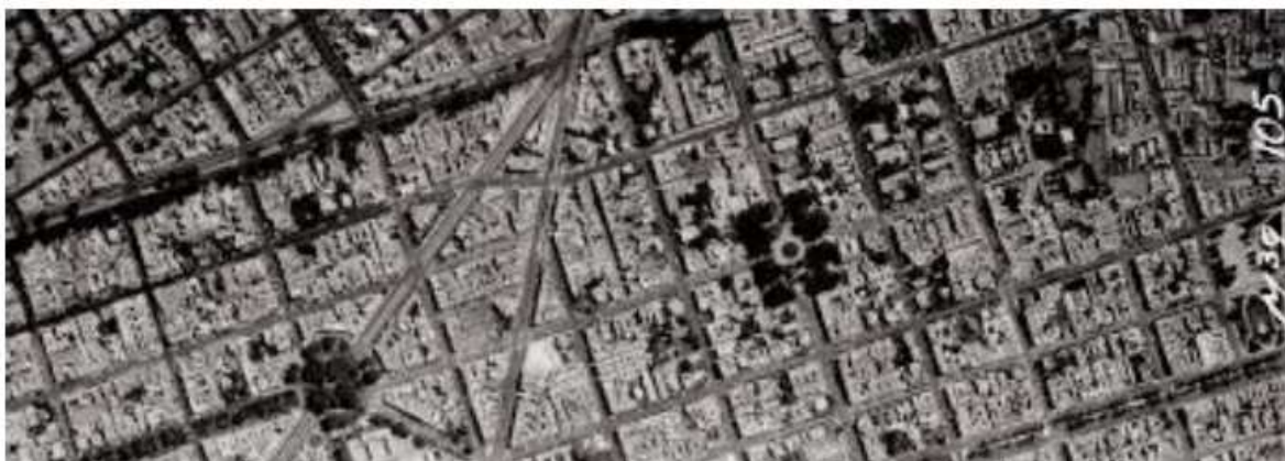
Imagen 6. Vista aérea vertical del Distrito II de la colonia Roma Norte en la década de los 30s siglo pasado
