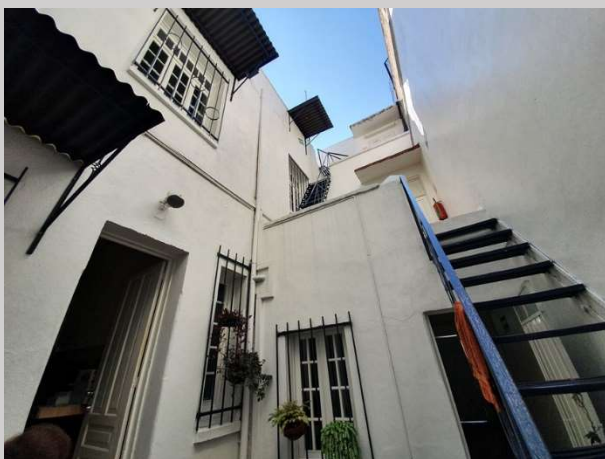
PATIO DE SERVICIO
