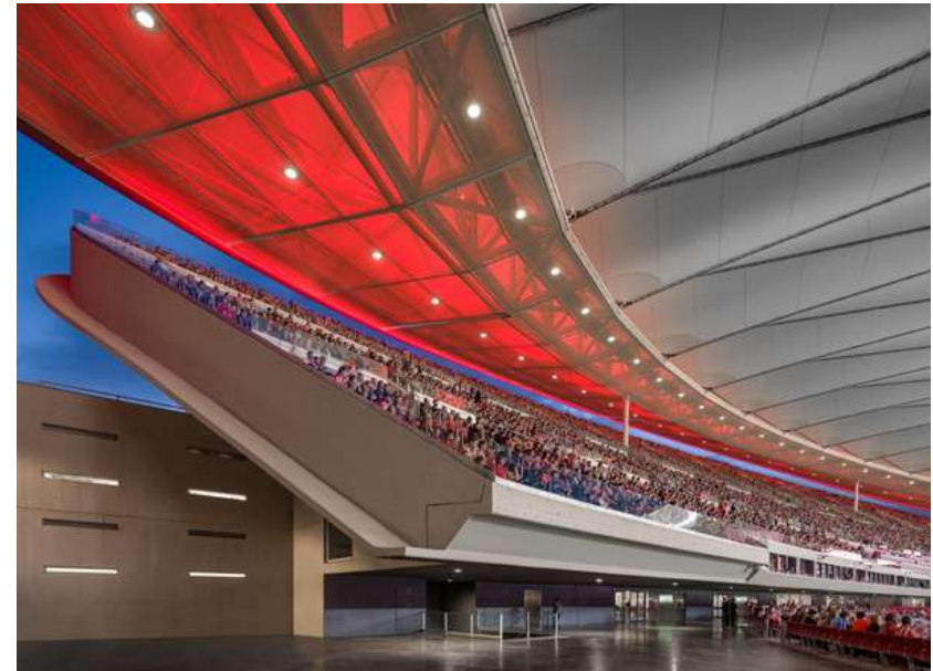
Imagen 150. (2017) Estadio Wanda Metropolitano interior. Recuperado de: https://bit.ly/3r3gnfI
