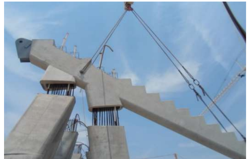
Imagen 61. (2017) Unión de prefabricados con la estructura colada en sitio. Cortesía de ITISA GRUPO.
