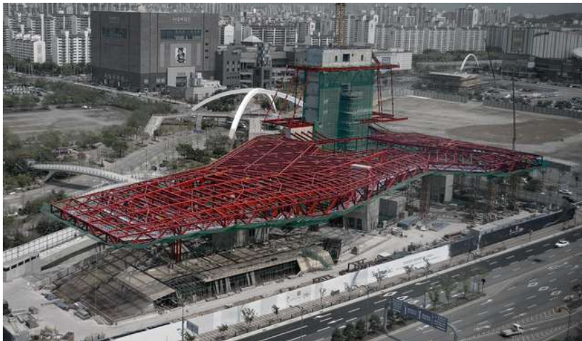
Imagen 68. (2019) Construcción de la cubierta metálica. Recuperado de: https://bit.ly/3hvM5yw
