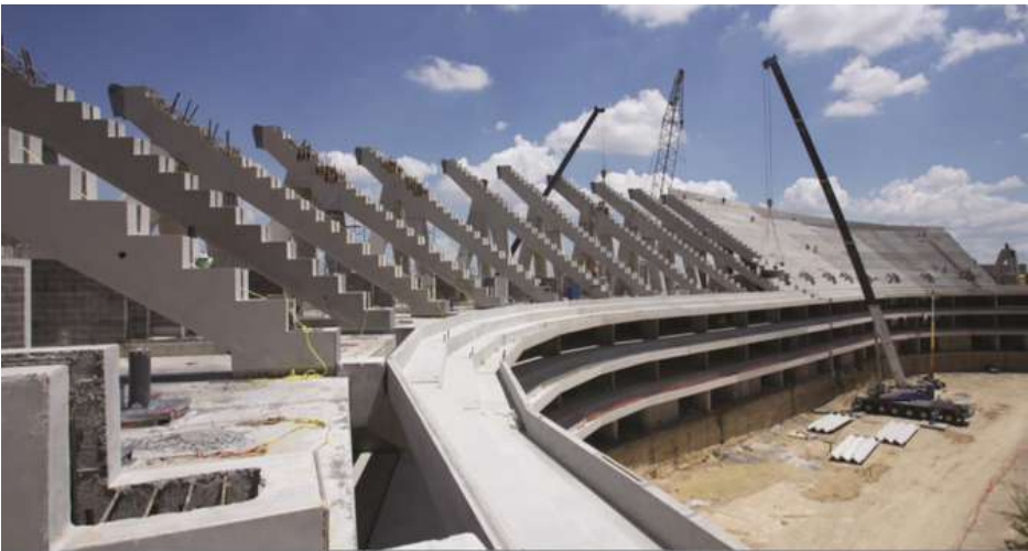
Imagen 64. (2017) Instalación de elementos prefabricados Cortesía de ITISA GRUPO.
