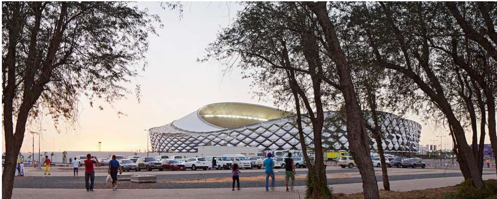
Imagen 26. (2015) Fachada Lateral - Fotografía. Recuperado de https://bit.ly/2xS8rb9
