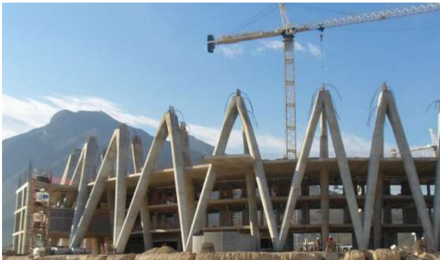
Imagen 60. (2017) Estructura colada en sitio. Cortesía de ITISA GRUPO.
