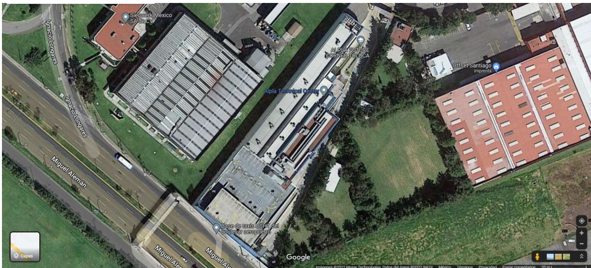
Área de estudio toma aérea del centro técnico Toluca.
