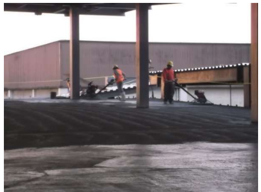
Imagen 1,2,3,4,5,6. Colocación losacero, pernos nelson tendido de malla de entrepiso, colado.
