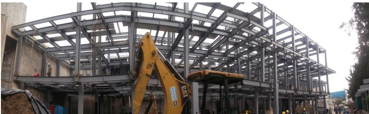
Imagen 1,2,3,4,5,6. Montaje de estructura en nivel 104.70 y 108.27 y nivel azotea.
