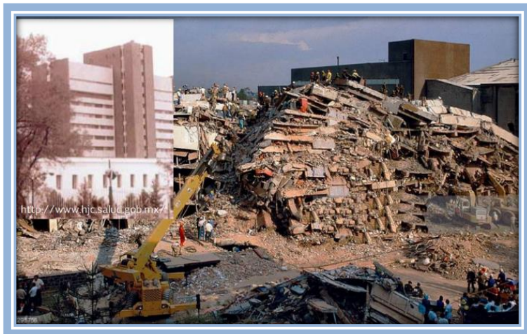
FIGURA 3 Colapso de la estructura del Hospital Benito Juárez, Ciudad de México. Fuente: CENAPRED, 2016
