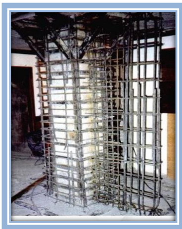
FIGURA 17 Encamisado de columnas Fuente: CENAPRED, 2016
