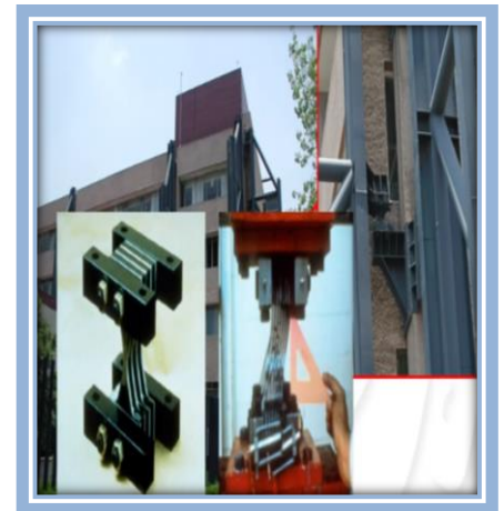
FIGURA 19 Disipadores de energía Fuente: CENAPRED, 2016
