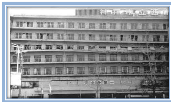
FIGURA 8 Colapso del quinto piso del hospital municipal de Kobe, 1995 Fuente. CENAPRED, 2016
