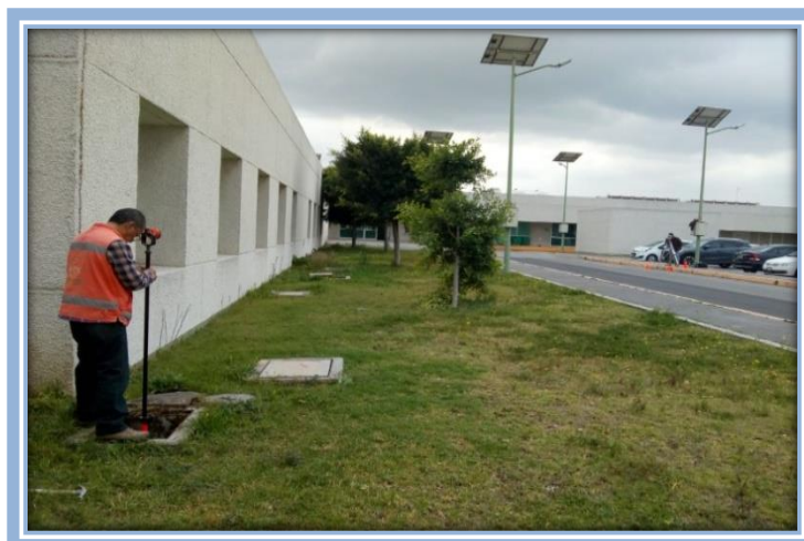
FIGURA 33 Nivelación de arrastre de instalación pluvial y sanitaria.
