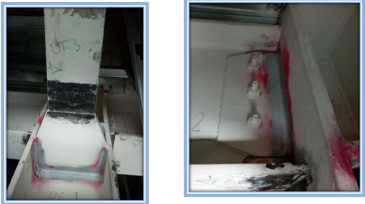
FIGURA 37 Ultrasonido en columna eje m-16, para detección de discontinuidades en la soldadura.
