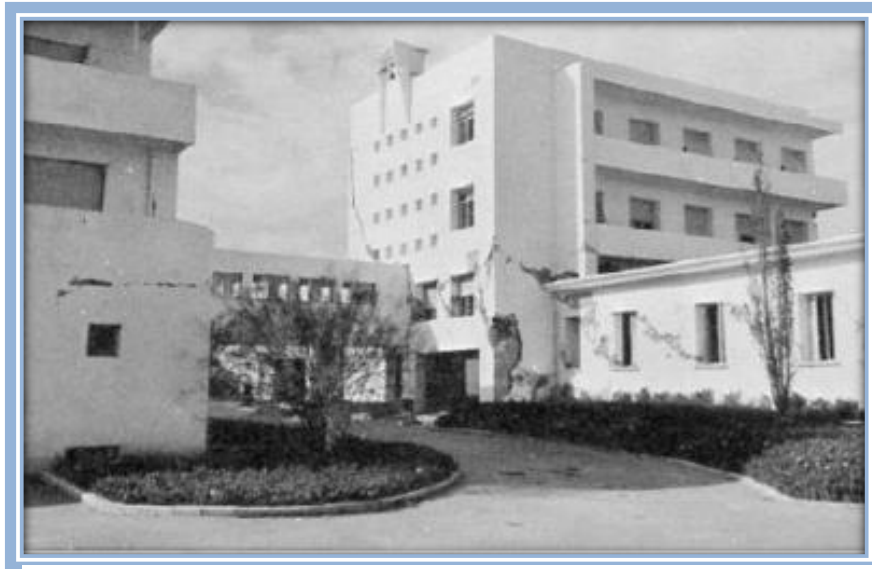
FIGURA 9 Choque entre edificios, Hospital port Lyautey, Marruecos. Sismo de 1960 Fuente. CENAPRED, 2016
