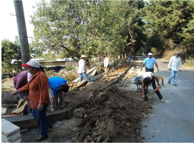
Imagen 36 Trabajos de construcción de banquetas.
