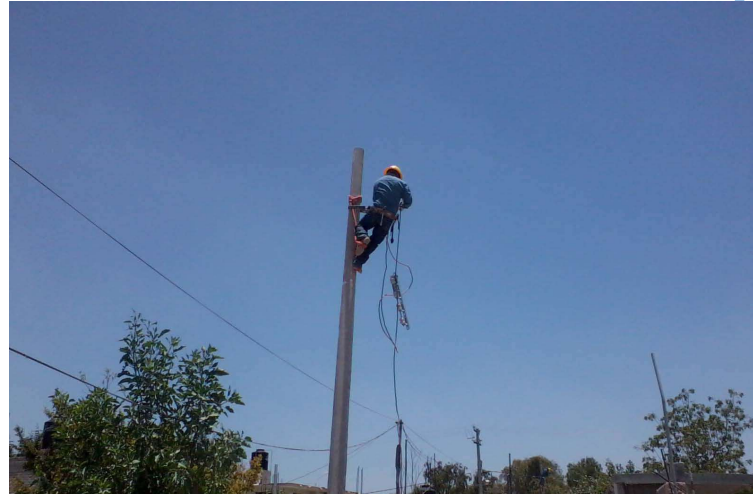
Imagen 37 Trabajos de mantenimiento de red eléctrica.
