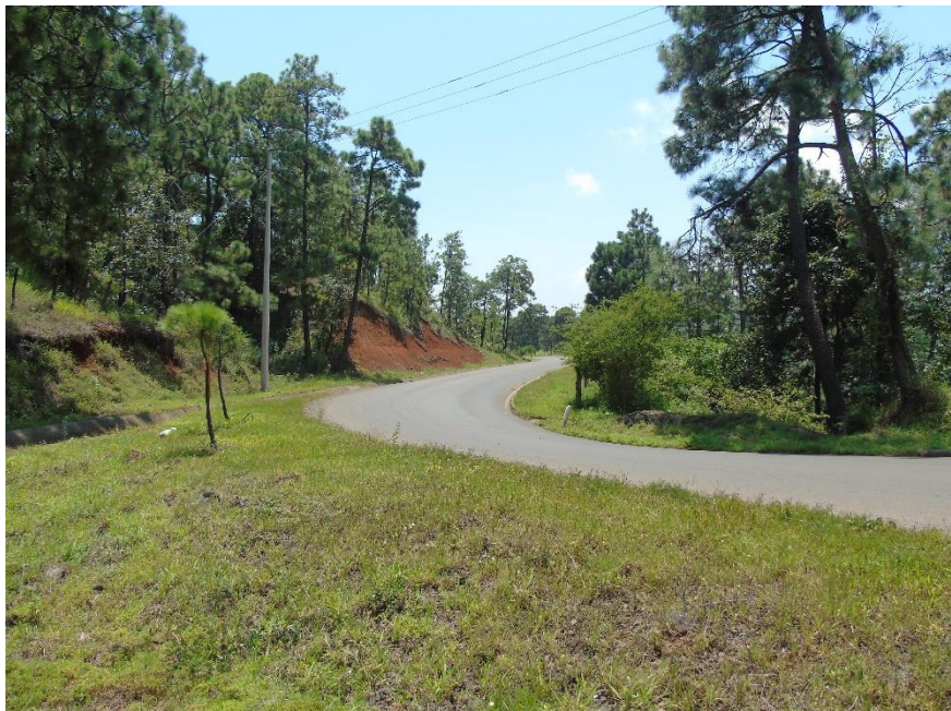
Figura 3.6.- Inicio del tramo carretero a analizar.
