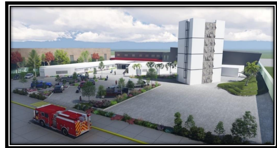
Vista de conjunto de la parte posterior del edificio
